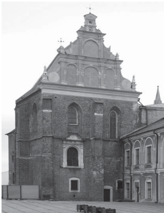
Kaplica pw. Świętej Trójcy, widok od dziedzińca zamkowego. Fot. J. Zętar.
