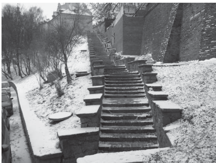
Zaulek Władysława Panasa – schody prowadzące z ul. Podwale na pl. po Farze. Fot. M. Skrzypek.
