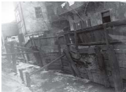
Dzielnica żydowska, „przełom” Czechołki przed jej zasklepieniem, które rozpoczęło w 1938 roku. Ze zbiorów MPWiK w Lublinie.
