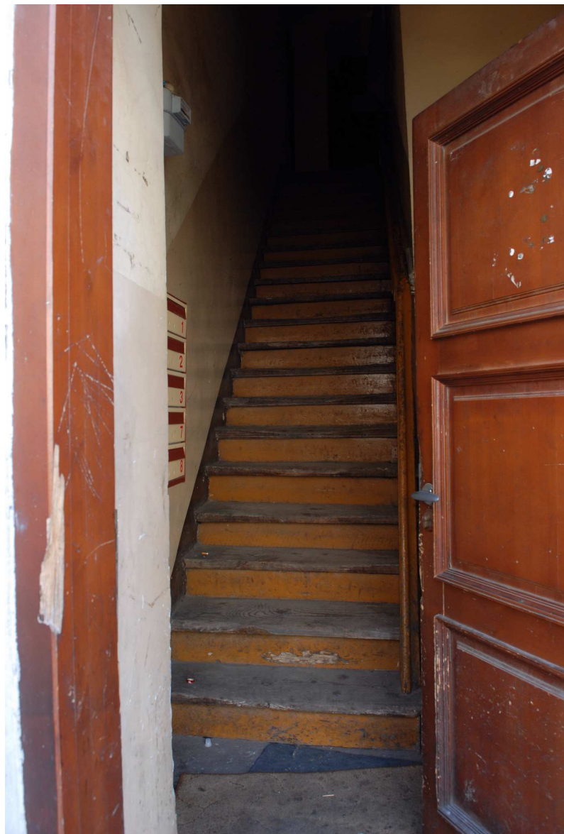
Klatka schodowa, Kowalska 15, fot. Marcin Moszyński, 2010.
