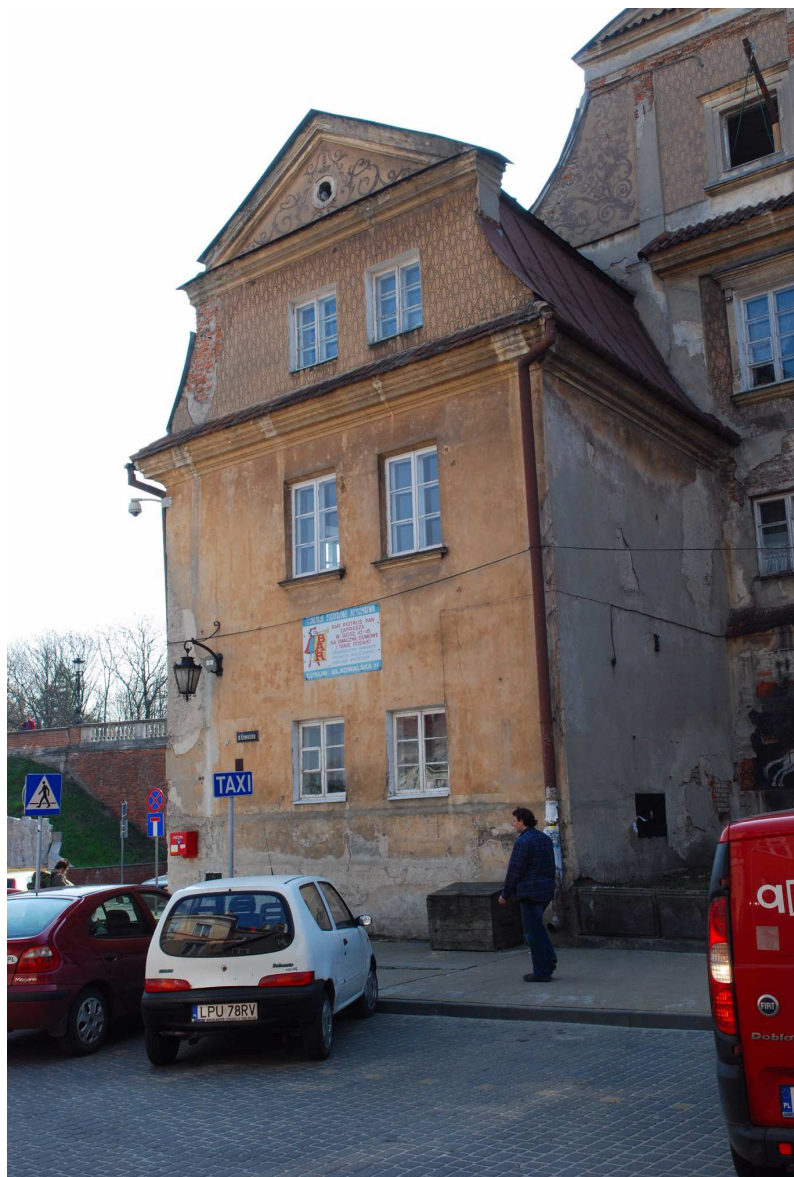
Elewacja boczna, Kowalska 17, fot. Marcin Moszyński, 2010.
