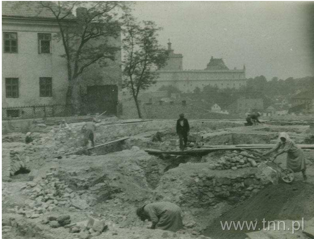
Prace konserwatorskie przy fundamencie dawnego kościoła św. Michała, autor nie znany, 1938, Wydział Architektury, Budownictwa i Urbanistyki Urzędu Miasta Lublin
