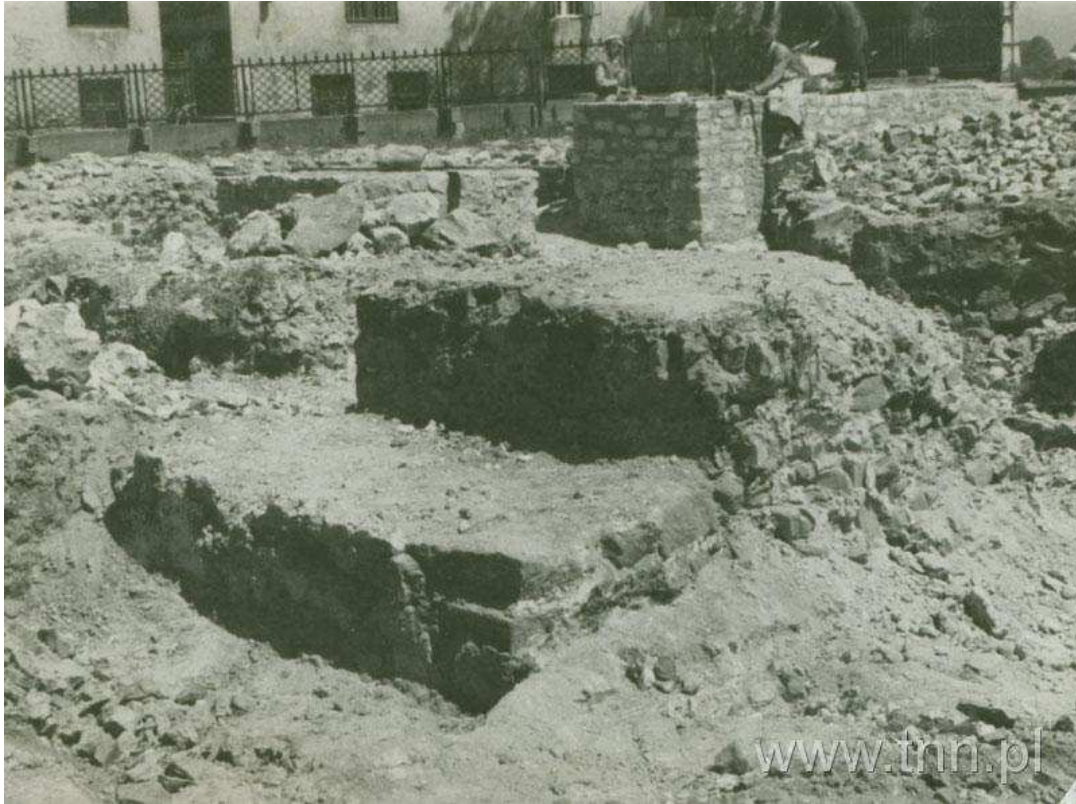
Filar sklepienia międzynawowy - dawny kościół św. Michała, autor nie znany, 1938, Wydział Architektury, Budownictwa i Urbanistyki Urzędu Miasta Lublin
