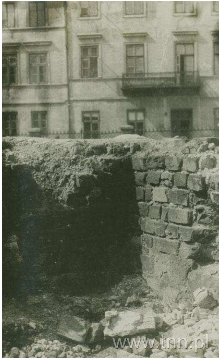
Fragment muru dawnego grobowca Lubomelskich w kościele św. Michała, autor nie znany, 1938, Wydział Architektury, Budownictwa i Urbanistyki Urzędu Miasta Lublin
