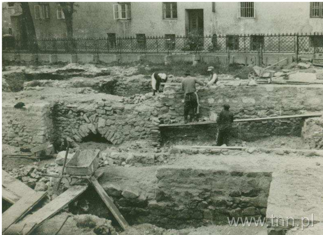
Prace konserwatorskie przy fundamencie dawnego kościoła św. Michała, autor nie znany, 1938, Wydział Architektury, Budownictwa i Urbanistyki Urzędu Miasta Lublin
