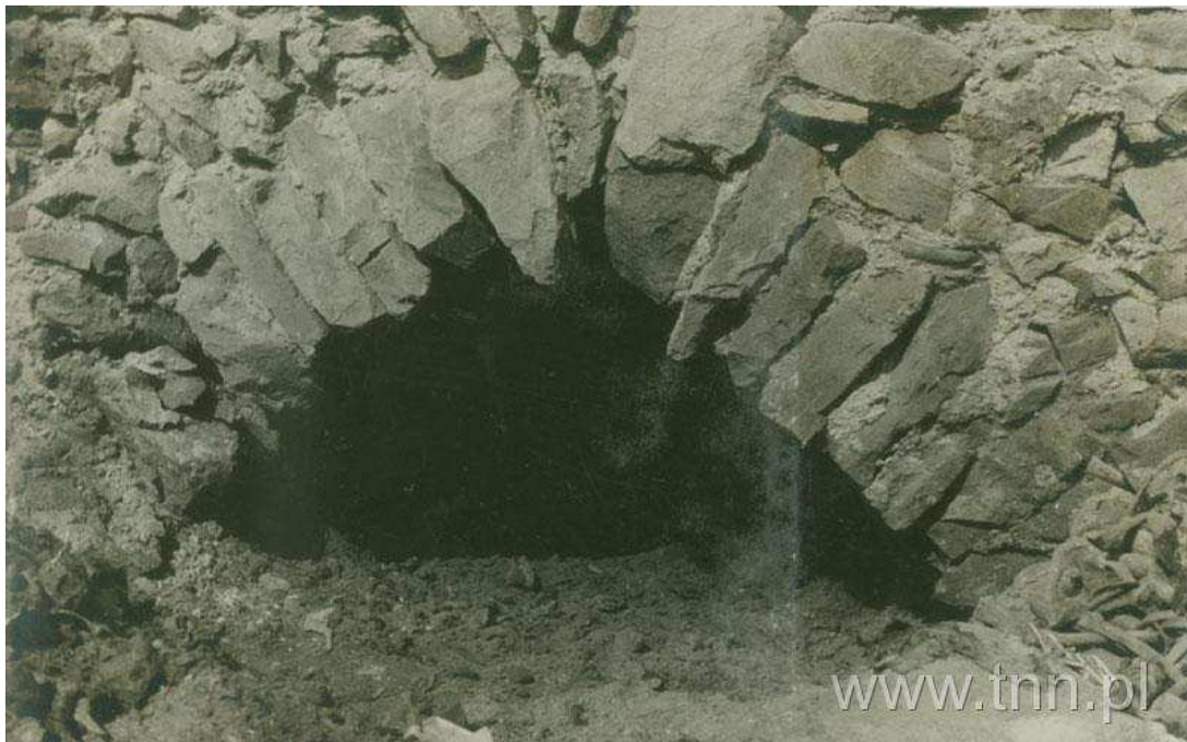
Widok na odkryte sklepienie w murze fundamentów w kościele św. Michała, autor nie znany, 1938, Wydział Architektury, Budownictwa i Urbanistyki Urzędu Miasta Lublin
