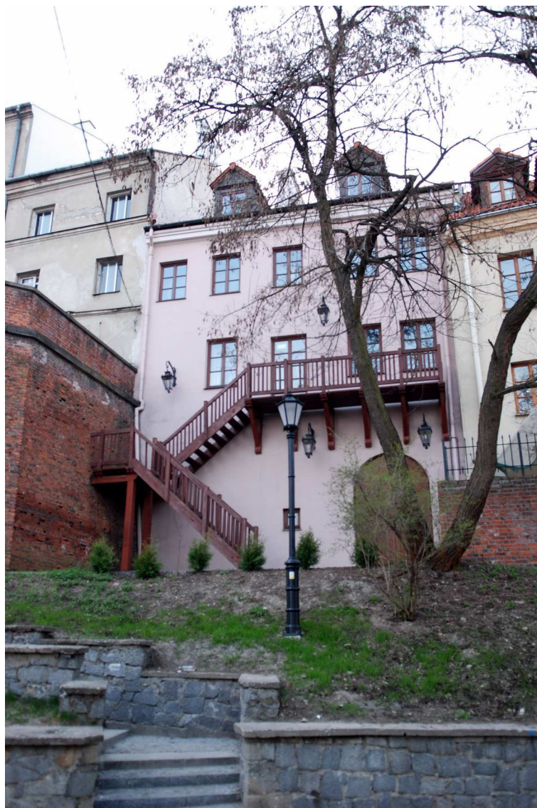
Elewacja tylna, Grodzka 19, fot. Marcin Moszyński, 2010.
