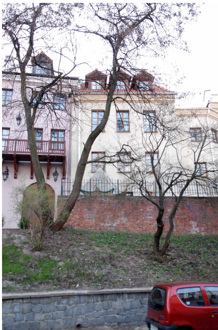
Elewacja tylna, Grodzka 19, fot. Marcin Moszyński, 2010.
