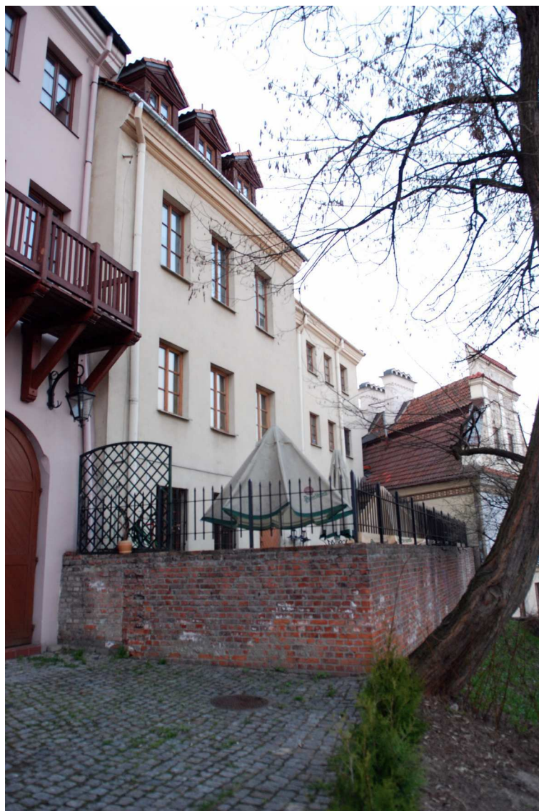
Elewacja tylna, Grodzka 19, fot. Marcin Moszyński, 2010.
