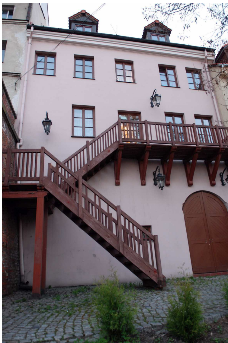
Elewacja tylna, Grodzka 19, fot. Marcin Moszyński, 2010.
