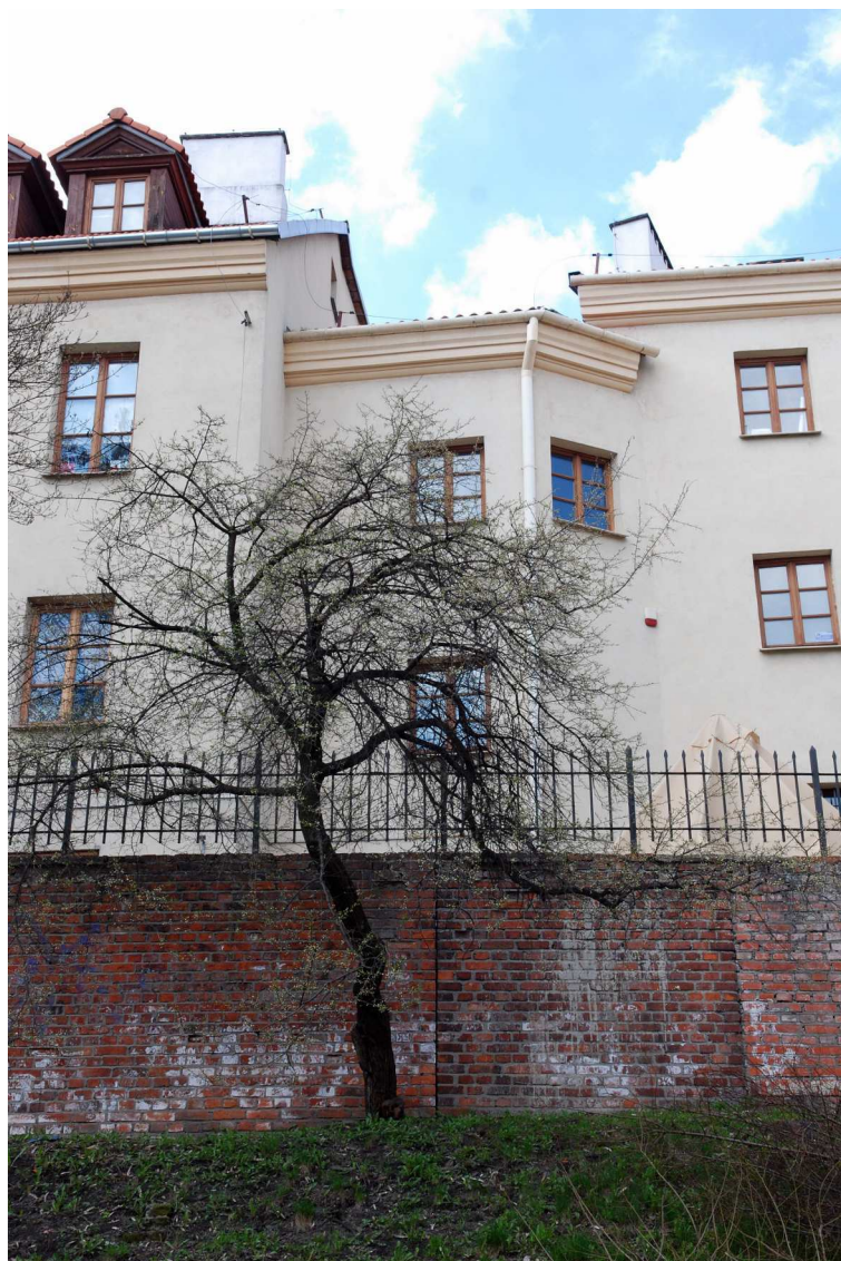
Elewacja tylna, Grodzka 19, fot. Marcin Moszyński, 2010.
