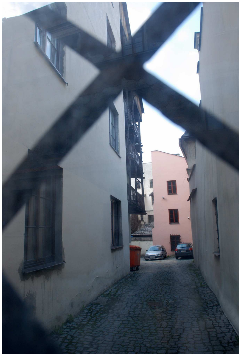
Elewacja boczna, Złota 2, fot. Marcin Moszyński, 2010.
