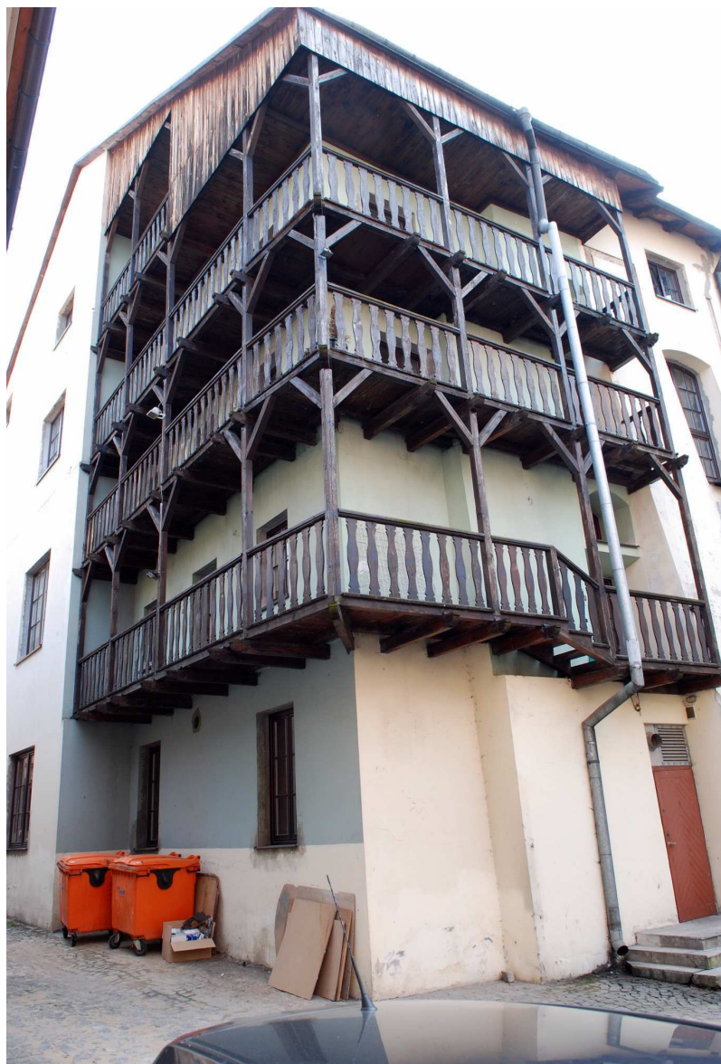
Elewacja boczna, Złota 1, fot. Marcin Moszyński, 2010.
