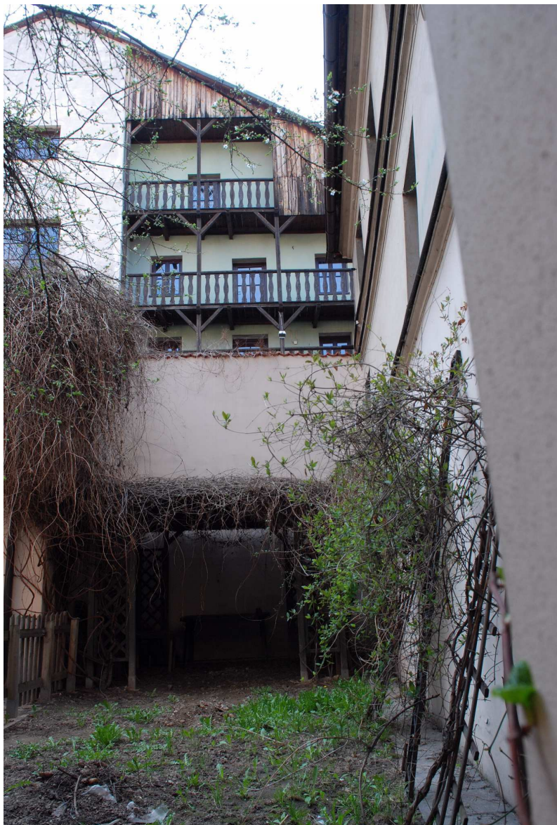
Elewacja tylna, Złota 2, fot. Marcin Moszyński, 2010.
