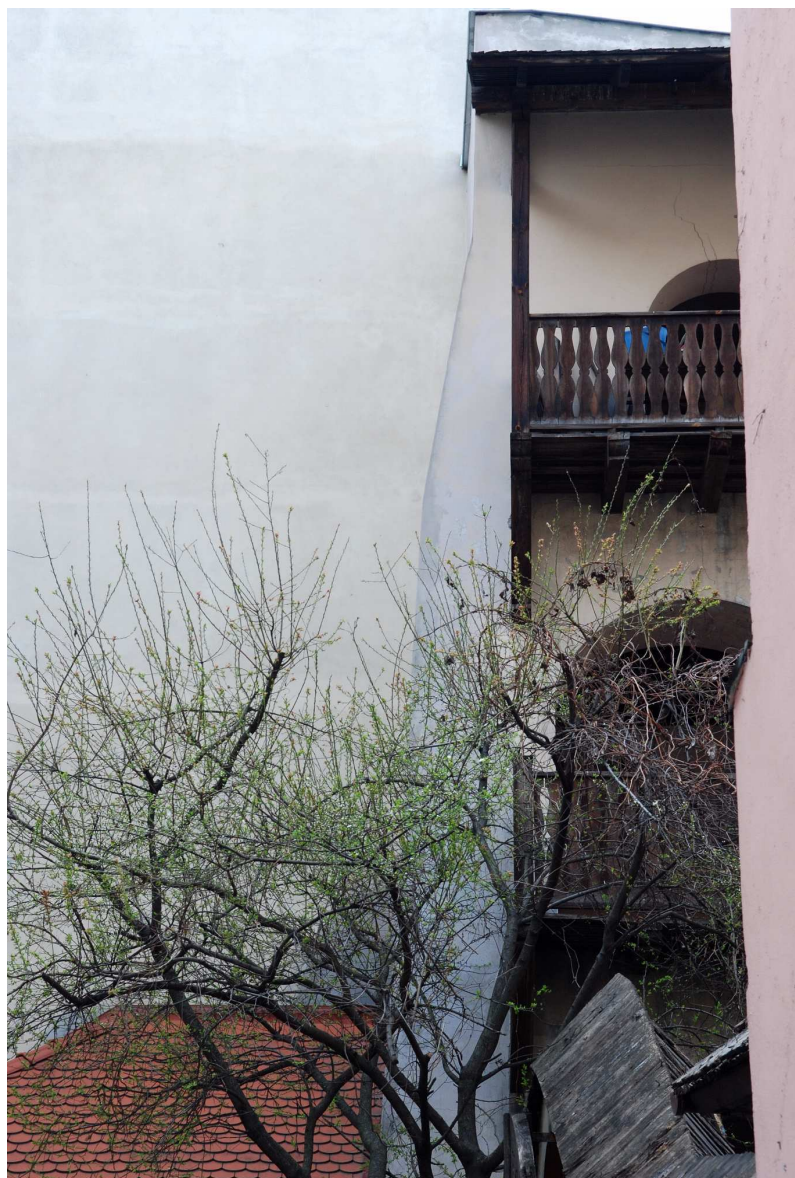
Elewacja boczna, Złota 2, fot. Marcin Moszyński, 2010.
