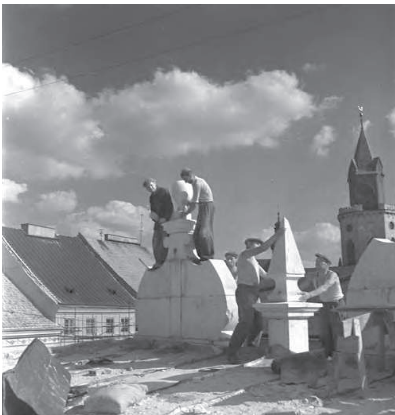
Odbudowa attyki na kamienicy przy Rynku. 1954. Fot. Edward Hartwig. Zbiory prywatne Ewy Hartwig-Fijałkowskiej.
