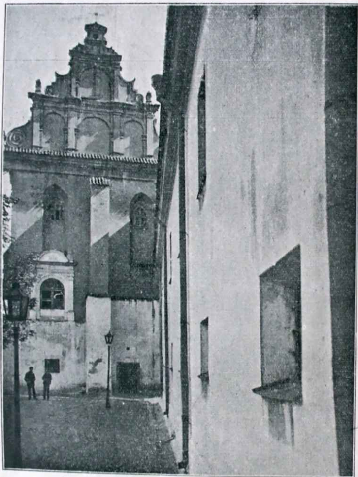
FASADA FRONTOWA KOŚCIOŁA ŚW. TRÓJCY na Zamku Lubelskim.
