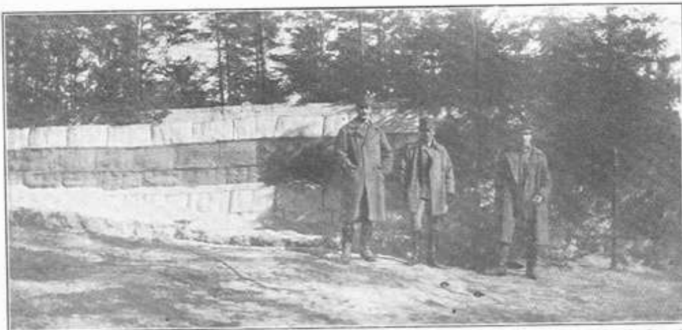
Trawersy z worków, oplecionych drutem i napełnionych stwardniałym na kamień piaskiem.
