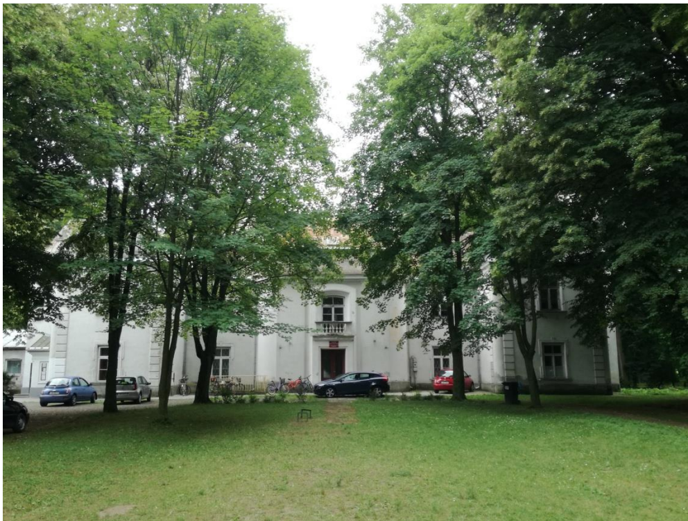
Pałac od strony północnej (fot. D. Spodar, dn. 15.06.2018r.)
