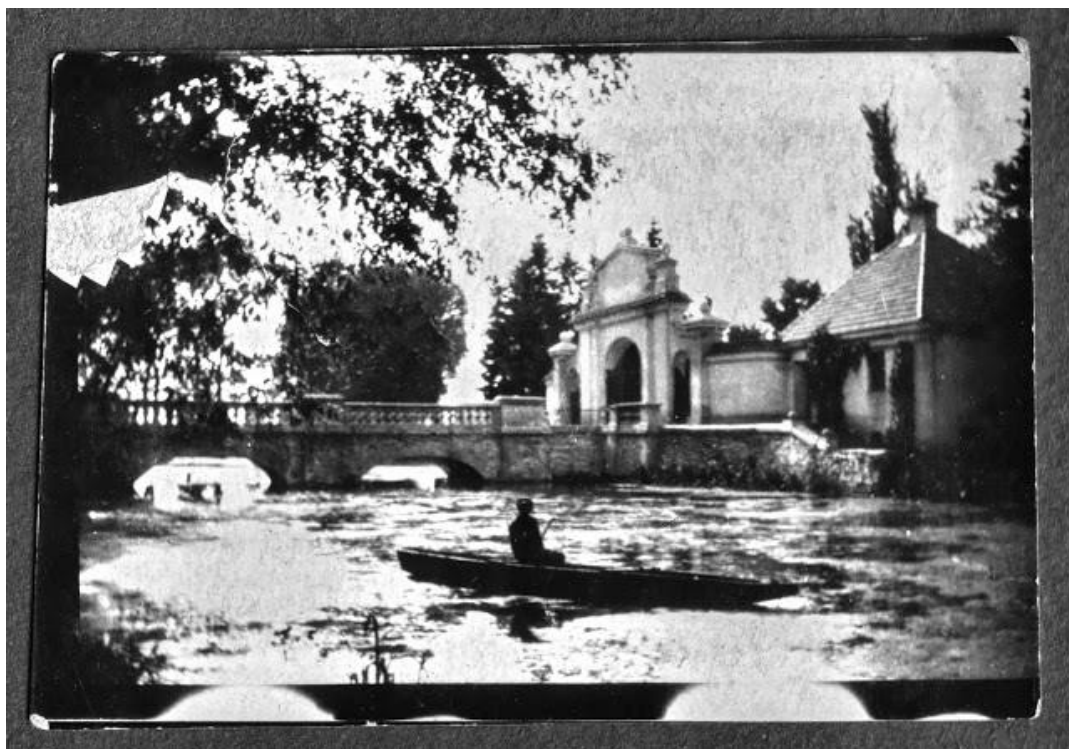
Fot. 1 Brama północna. 48
