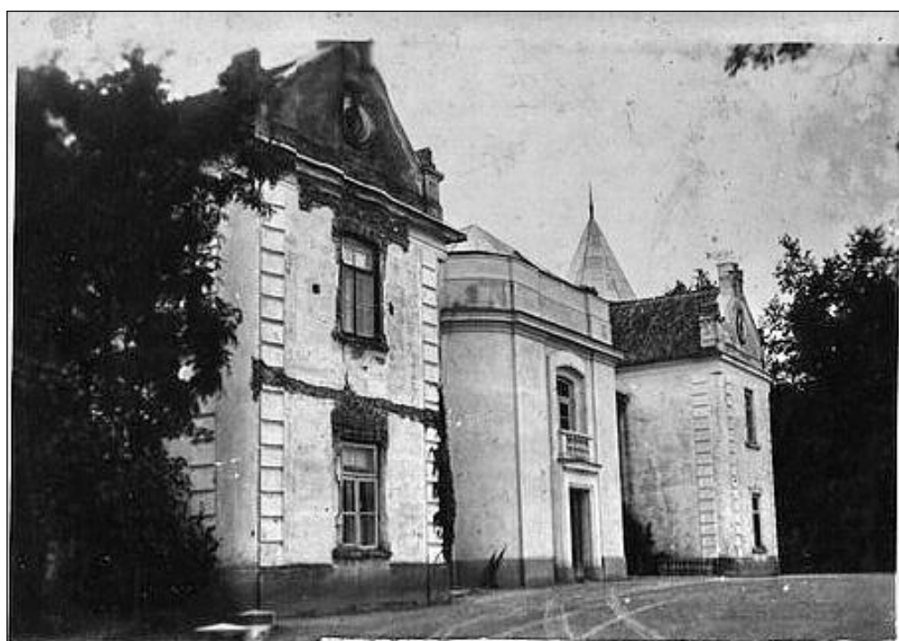
Fot. 6 Fasada północna, prawdopodobnie rok 1922, widoczne zmiany w głównym wejściu.
