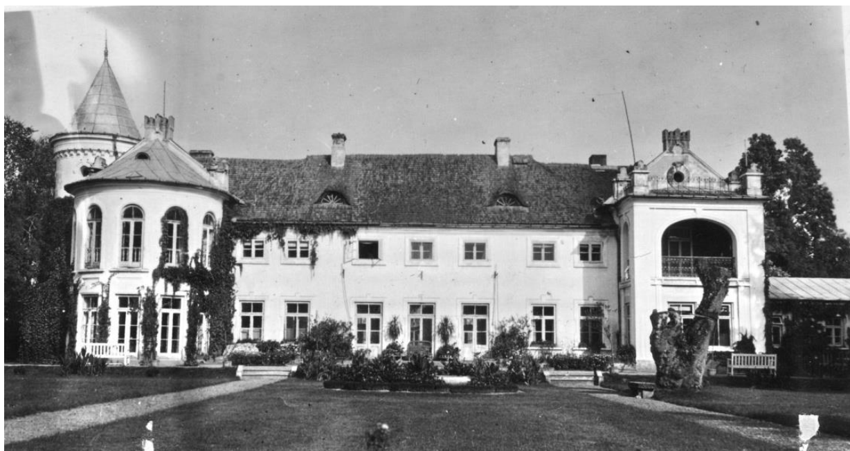
Fot. 4. Fasada południowa, zdjęcie wykonano prawdopodobnie po I wojnie światowej.
