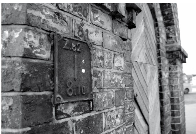
Studzienka przed remontem – detal, 2008 r., fot. Marcin Moszyński
