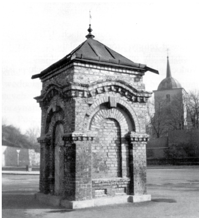
Fotografia studzienki z: S. Michałowski, Sto lat współczesnych wodociągów w Lublinie 1899–1999 , Lublin 1999
