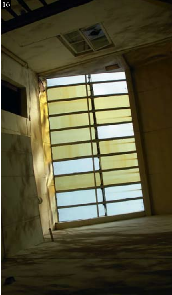
16. Świetlik w dachu nad klatką schodową, istniejący do ostatniego remontu kamienicy (fot. K. Janus).
