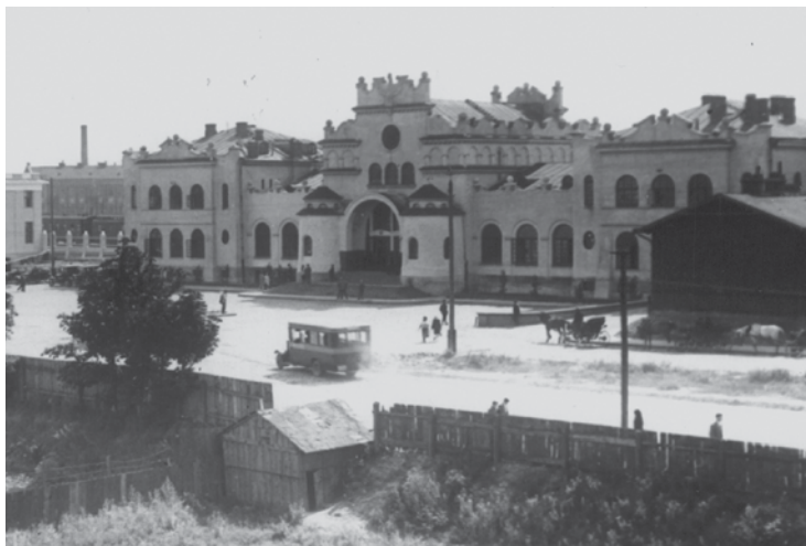
Dworzec kolejowy w Lublinie, 1930 r., fot. Franciszek Litwińczuk. Zbiory Wojciecha Turzańskiego.
