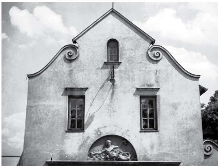
Widok fragmentu domu „Syrena”, 1939 r. Zbiory NAC.
