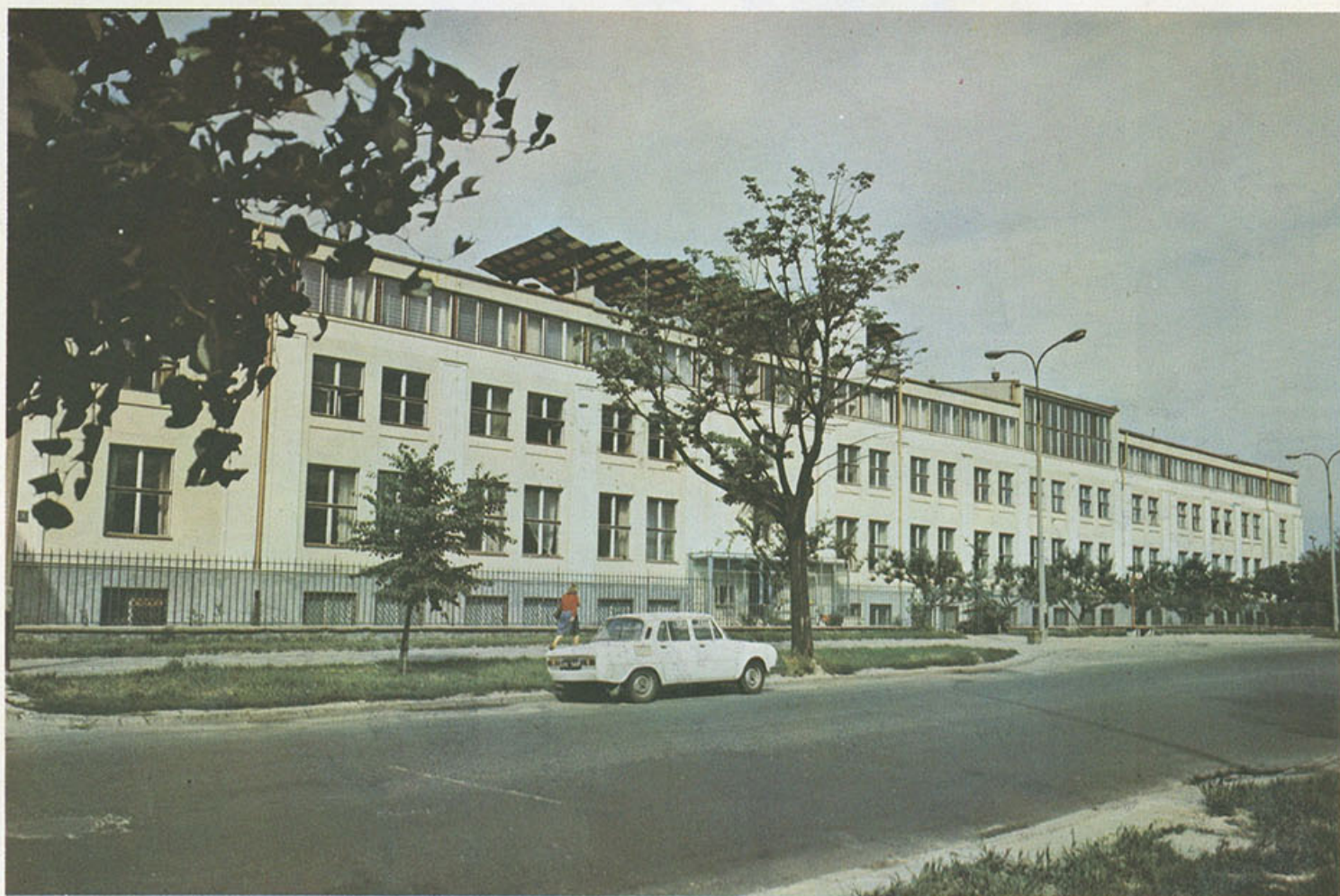
Budynek Lubelskich Zakładów Graficznych im. PKWN w Lublinie przy ul. Unickiej 4 po zakończonej modernizacji
