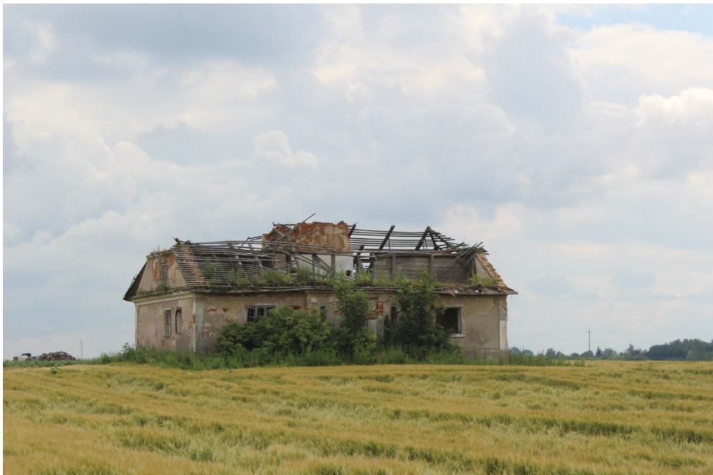
Fot. 26. Dwór w Kotlicach w 2020 roku
