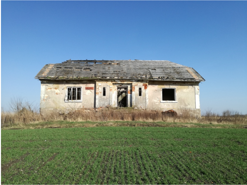
Fot. 25. Dwór w Kotlicach w 2018 roku
