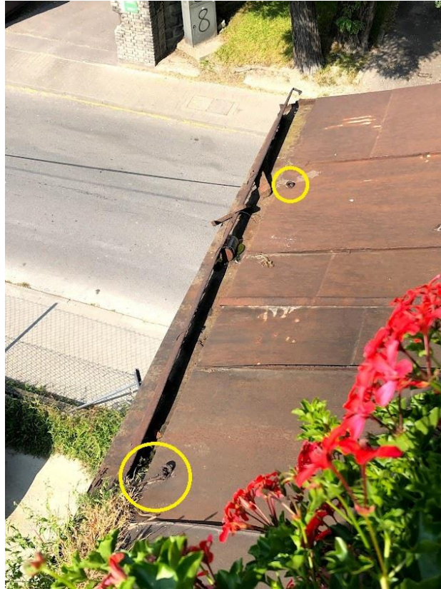
14. Kuczka na kamienicy przy ul. Reformackiej 23A w Chełmie. Dach kuczki widziany z góry. Oznaczono ogniwa do podnoszenia kłap, do których mocowano koniec linki stalowej. fot. Małgorzata Michalska – Nakonieczna, 2022 r.
