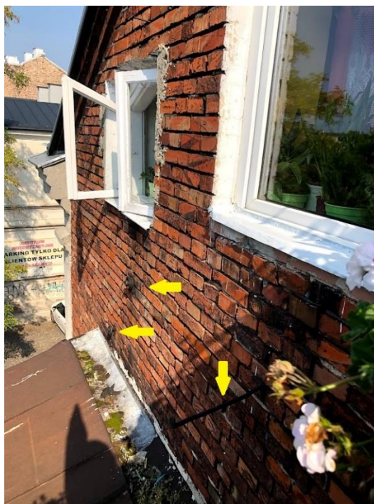
12. Kuczka na kamienicy przy ul. Reformackiej 23A w Chełmie. Elementy mechanizmu podnoszenia kłap dachowych, umieszczone w ścianie kamienicy, nad dachem kuczki, fot. Małgorzata Michalska – Nakonieczna, 2022 r.
