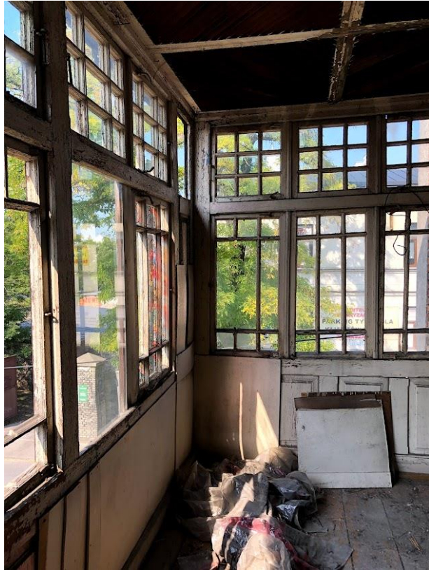
16. Wnętrze kuczki na kamienicy przy ul. Reformackiej 23A w Chełmie. Widok na południowy - zachód, fot. Małgorzata Michalska – Nakonieczna, 2022 r.
