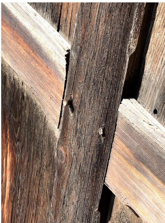
10. Kuczka na kamienicy przy ul. Reformackiej 23A w Chełmie. Sposób łączenia konstrukcji drewnianej na kołki, fot. Małgorzata Michalska – Nakonieczna, 2022 r.
