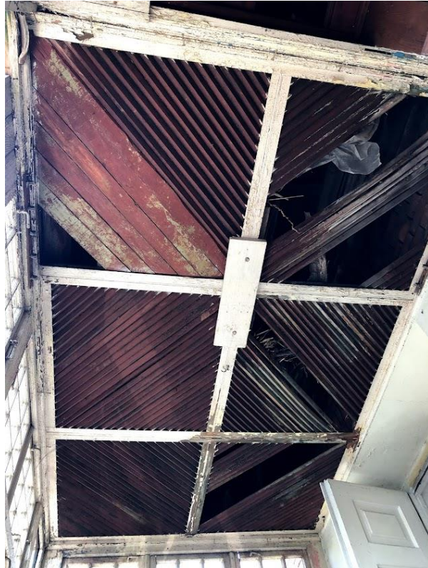
18. Wnętrze kuczki na kamienicy przy ul. Reformackiej 23A w Chełmie. Schach – rytualne przekrycie, fot. Małgorzata Michalska – Nakonieczna, 2022 r.
