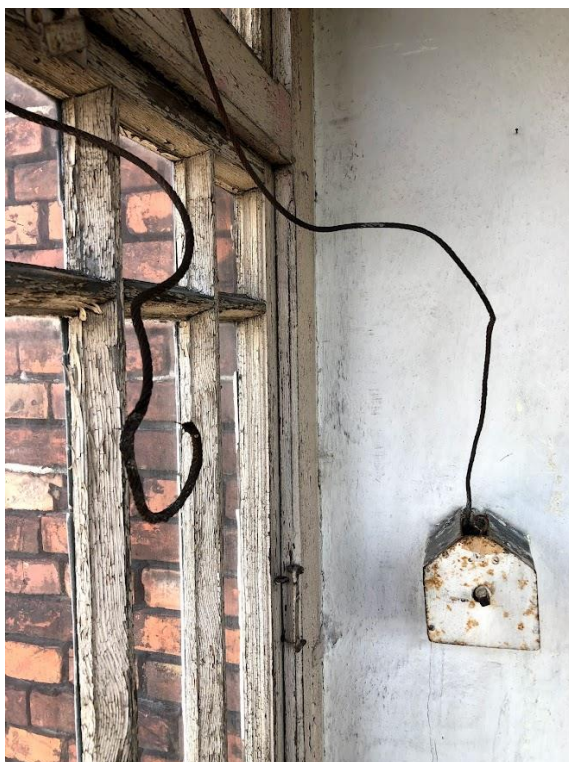
22. Wnętrze kuczki na kamienicy przy ul. Reformackiej 23A w Chełmie. Kołowrotek do podnoszenia kłap w dachu z fragmentem stalowej linki, fot. Małgorzata Michalska – Nakonieczna, 2022 r.
