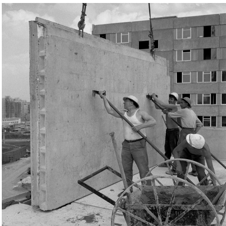
Budowa osiedla im. M. Konopnickiej, lata 70. XX w., fot Jacek Mirosław [archiwum autora].
