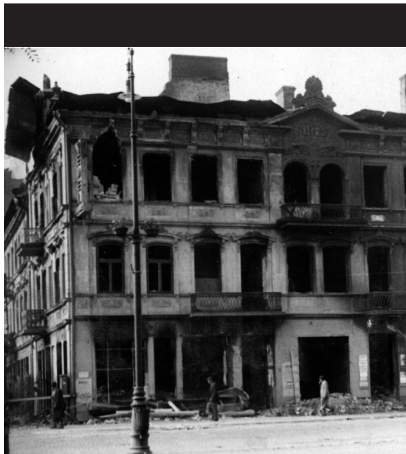
Zniszczona kamienica, Krakowskie Przedmieście 46
