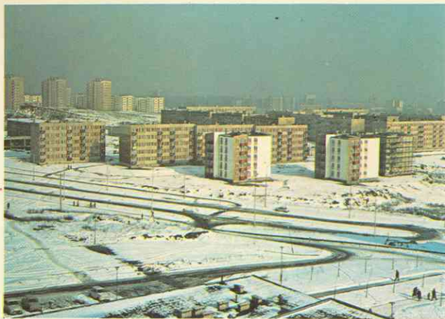
Osiedle im. B. Prusa w budowie
