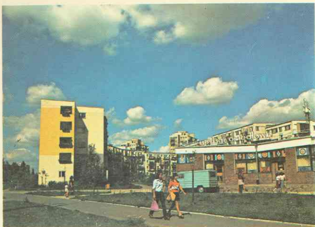
Usługi w osiedlu J. Słowackiego
