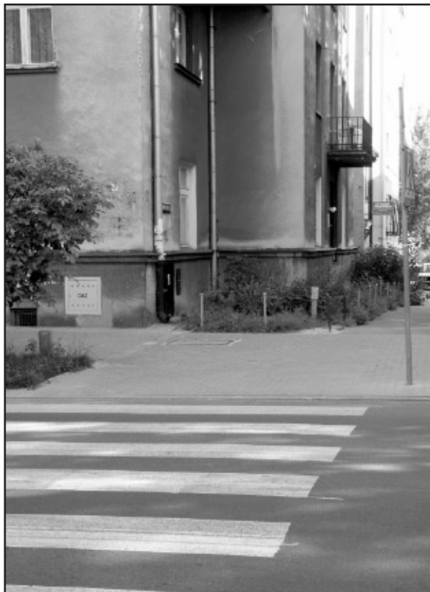
Wzorzec: krawężnik, którego nie widać!
