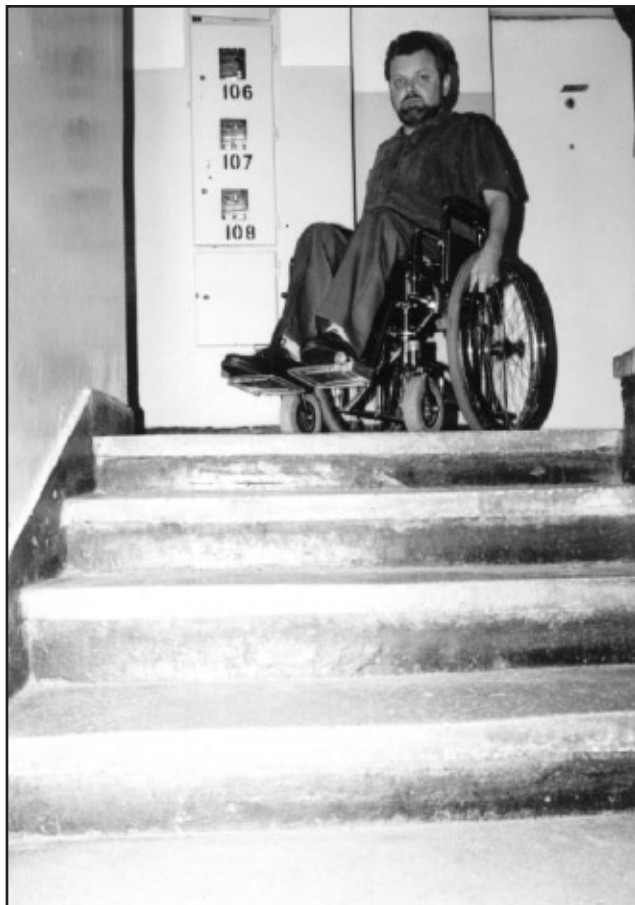
Puławy 1997, Pięć schodów - przeszkoda nie do pokonania.
