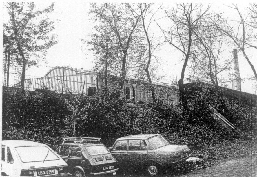
7. Lublin, Browar "Jeleń" ul. Kunickiego 106, magazyny, widok od półn.-wsch. Fot. J. Studziński 1995, neg. w pos. PSOZ
