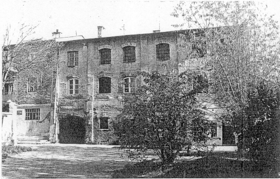
7. Młyn motorowy Freitag, ul. Zamojska 20 skrzydło frontowe z bramą przejezdną na wewnętrzne podworze. Fot. J. Studziński 1995, neg. w pos. PS0Z
