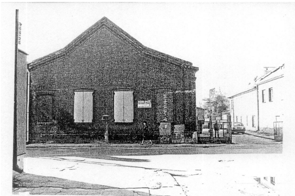
6.Lublin, Garbarnia H. Luchta, ul.Garbarska 2, Elewacja frontowa dobudówki z 1921 r. Fot. J.Studziński 1995, neg. w pos. PSOZ.
