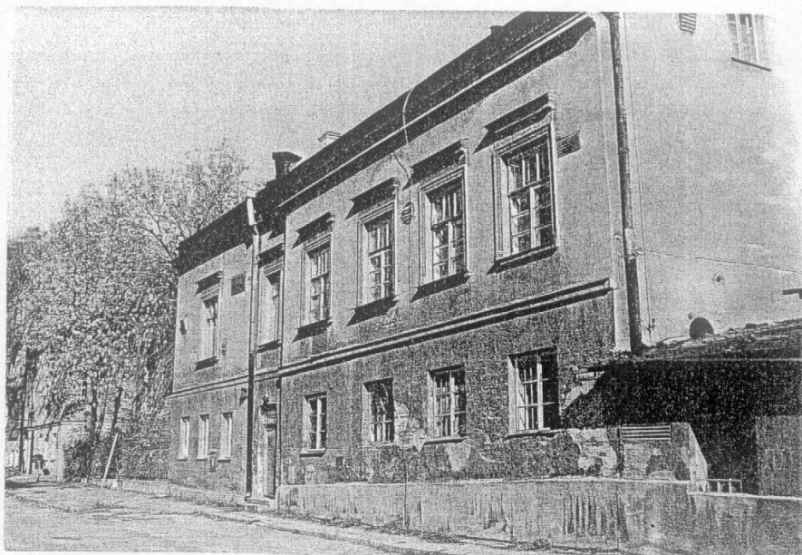
5. Południowe skrzydło pralni Łabęckich, elewacja zachodnia. Fot. J. Studziński, 1995; neg. w posiad. PSOZ Lublin.
