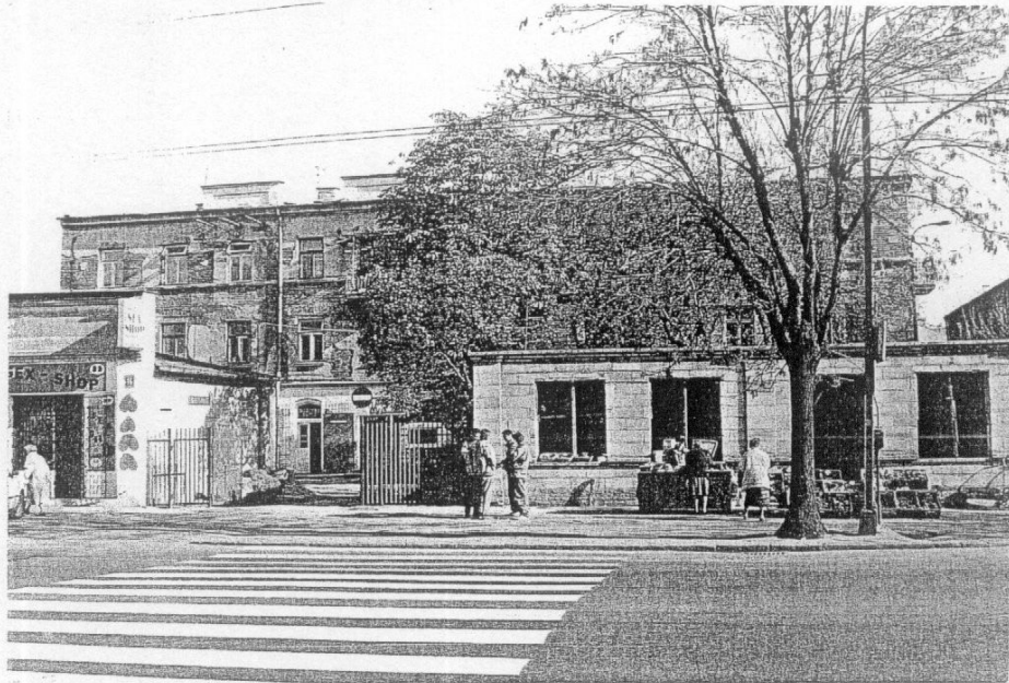
3) Dawna fabryka powozów, ul. Zamojska 16 / Przemysłowa 2, widok ogólny od strony ul. Zamojskiej. Fot. J. Studziński, 1995 ; neg. w posiadaniu PSOZ Lublin
