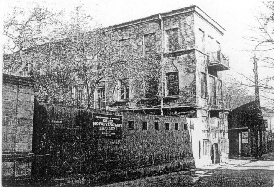
4) Dawna fabryka powozów skrzydło poprzeczne - fragment elewacji frontowej z attykami w zwieńczeniu i boczkiem wyciągowym na osi środkowej elewacji. Fot. J. Studziński, 1995 ; neg. w posiadaniu PSOZ Lublin.
