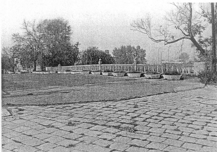
5) Most na Bystrzycy ciąg pieszy na moście. Fot. J. Studziński, 1995 ; neg. w posiad. PSOZ Lublin.
