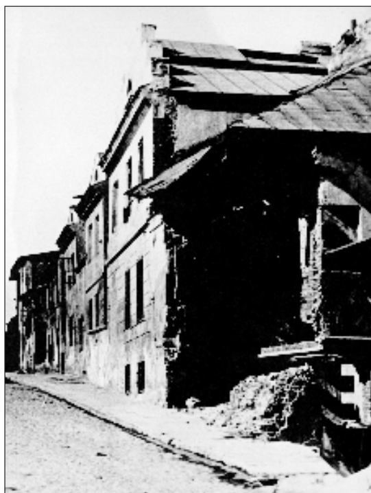
Zdjęcie z burzenia w 1943 ulicy Zamkowej.
