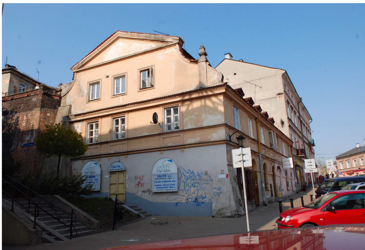
Elewacja boczna, Kowalska 3, fot. Marcin Moszyński, 2010.
