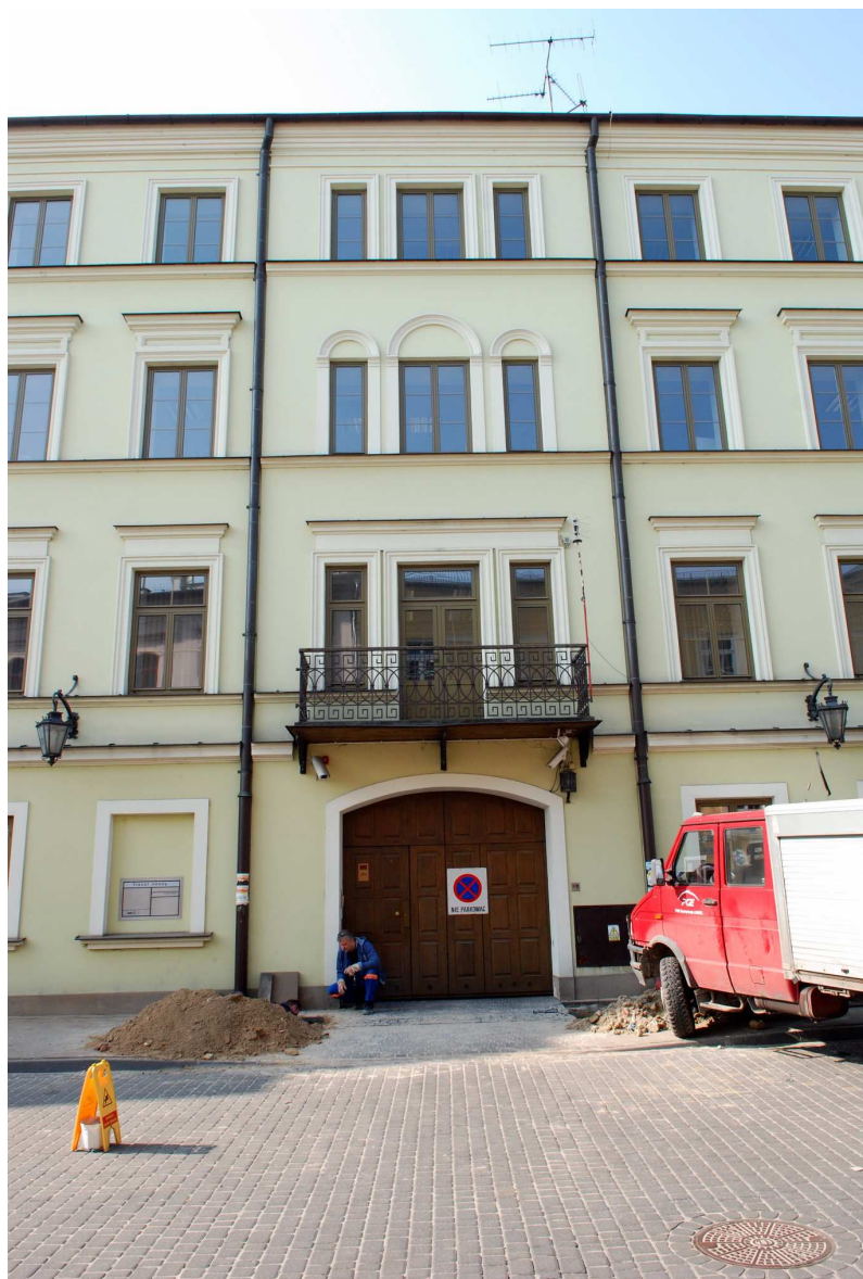
Elewacja boczna, Kowalska 5, fot. Marcin Moszyński, 2010.
