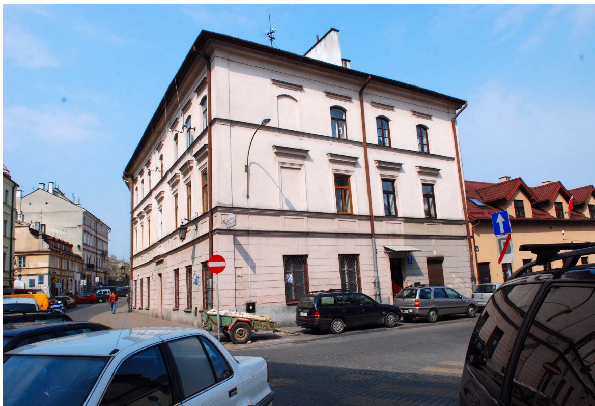
Elewacja boczna, Kowalska 6, fot. Marcin Moszyński, 2010.
