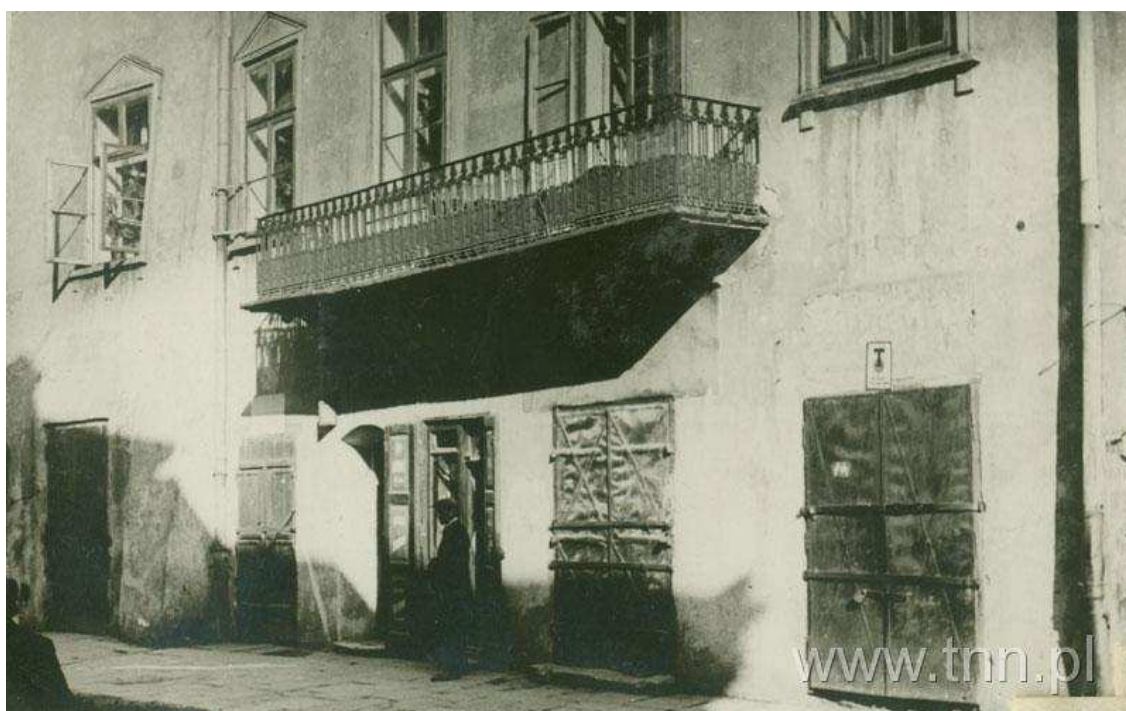
Bramowa 3/Jezuicka 2, widok dolnej części elewacji, 1938-1939, fot. nieznany, Wydział Architektury, Budownictwa i Urbanistyki Urzędu Miasta Lublin
