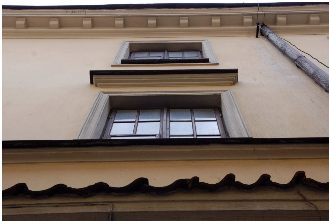
Fasada detale, Bramowa 8, fot. Marcin Moszyński, 2010.
