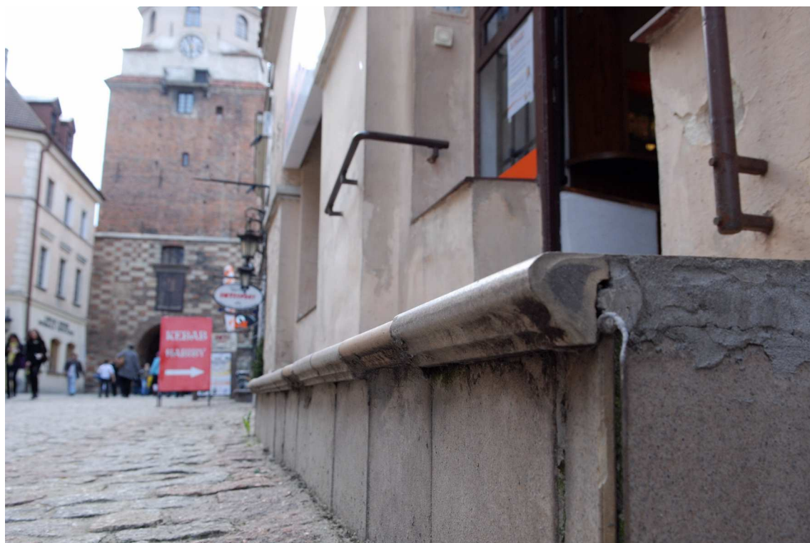
Fasada detale, Bramowa 8, fot. Marcin Moszyński, 2010.
