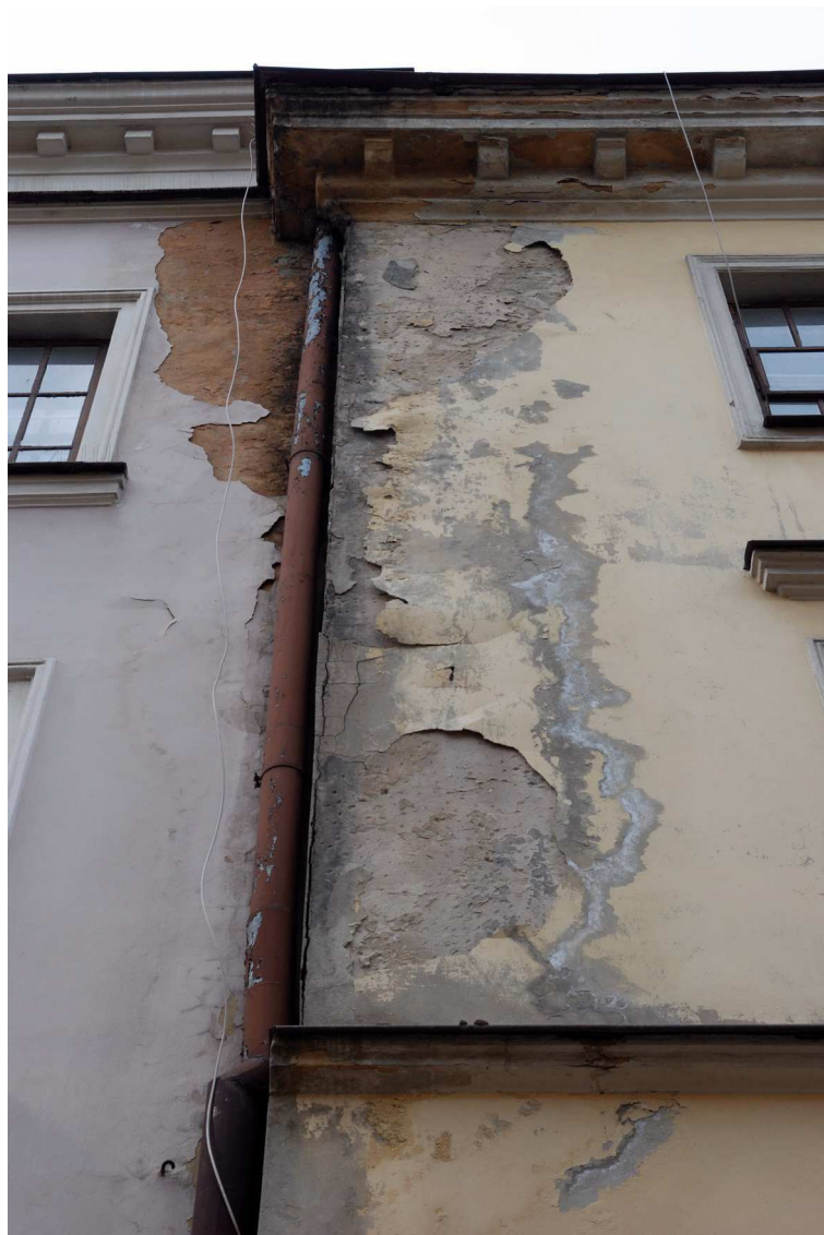
Fasada detale, Bramowa 8, fot. Marcin Moszyński, 2010.
