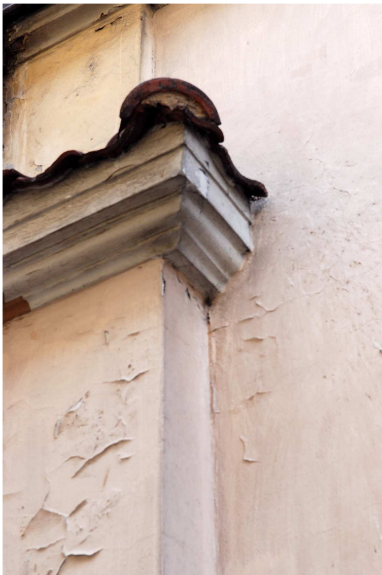
Fasada detale, Bramowa 8, fot. Marcin Moszyński, 2010.
