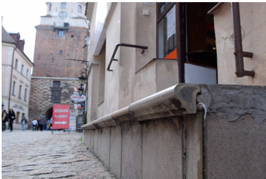
Fasada detale, Bramowa 8, fot. Marcin Moszyński, 2010.
