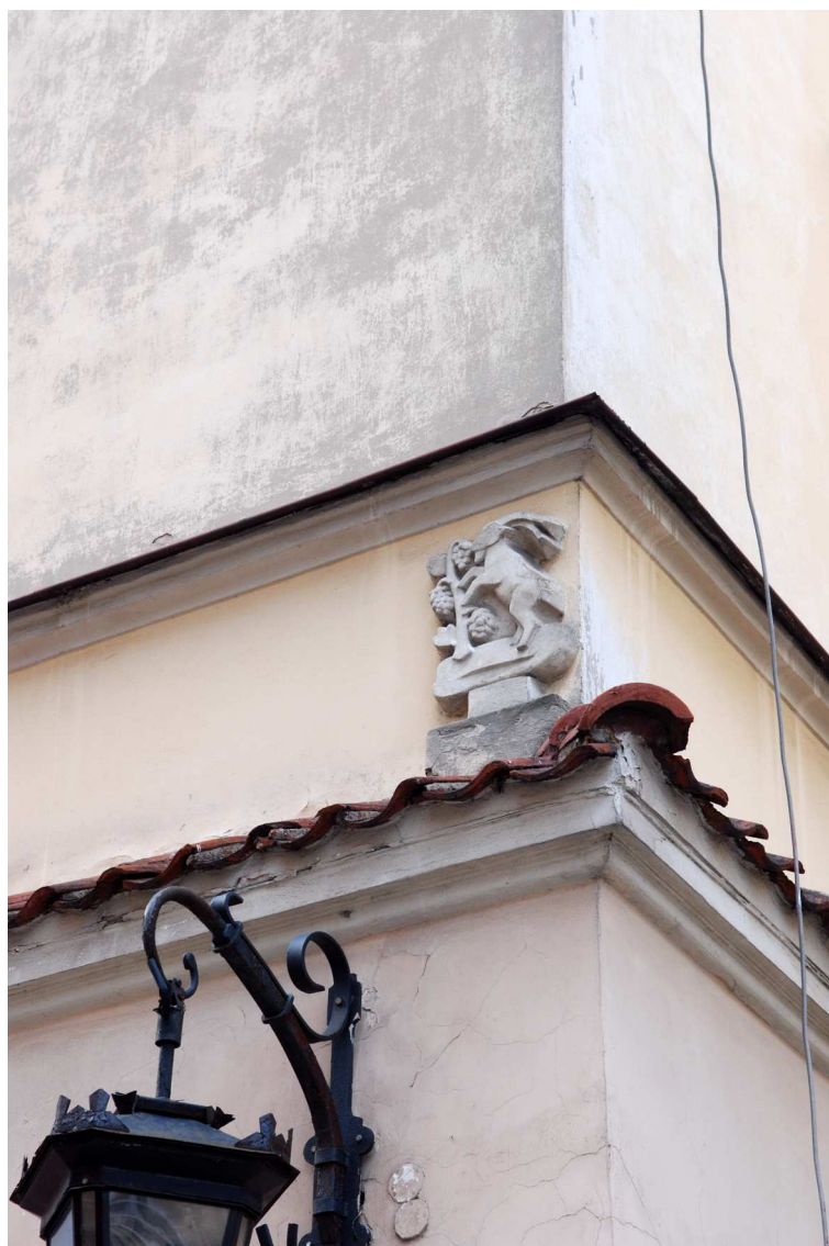
Fasada detale, Bramowa 8, fot. Marcin Moszyński, 2010.
