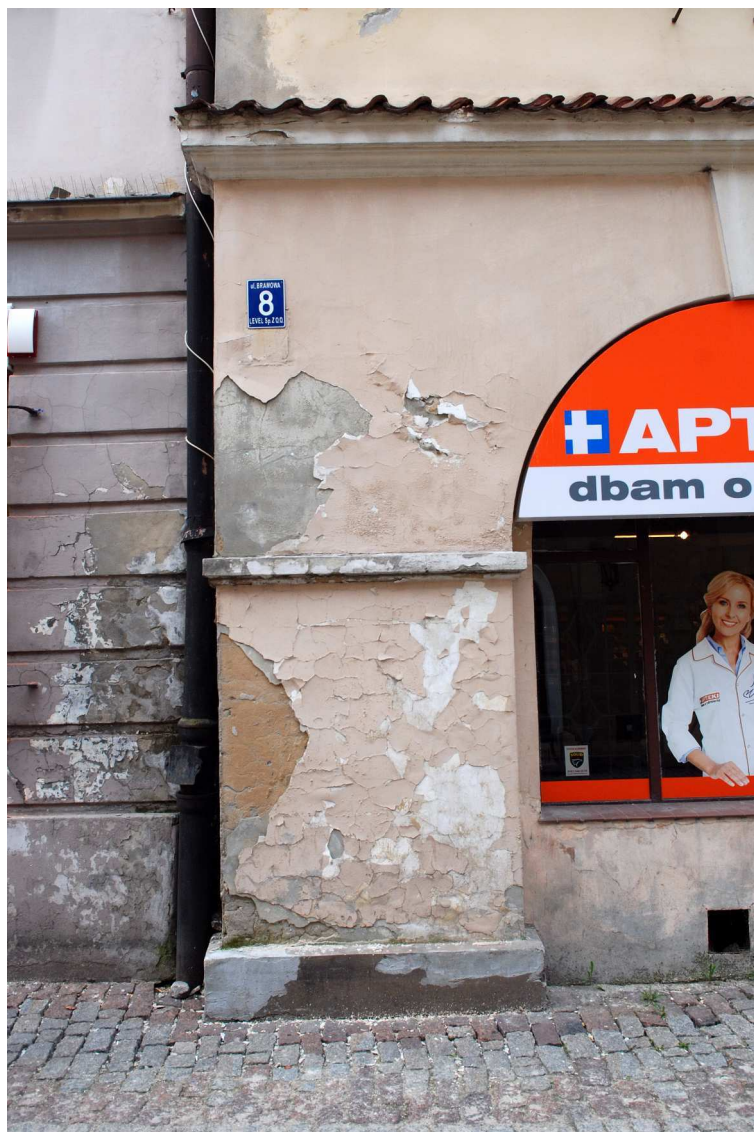
Fasada detale, Bramowa 8, fot. Marcin Moszyński, 2010.
