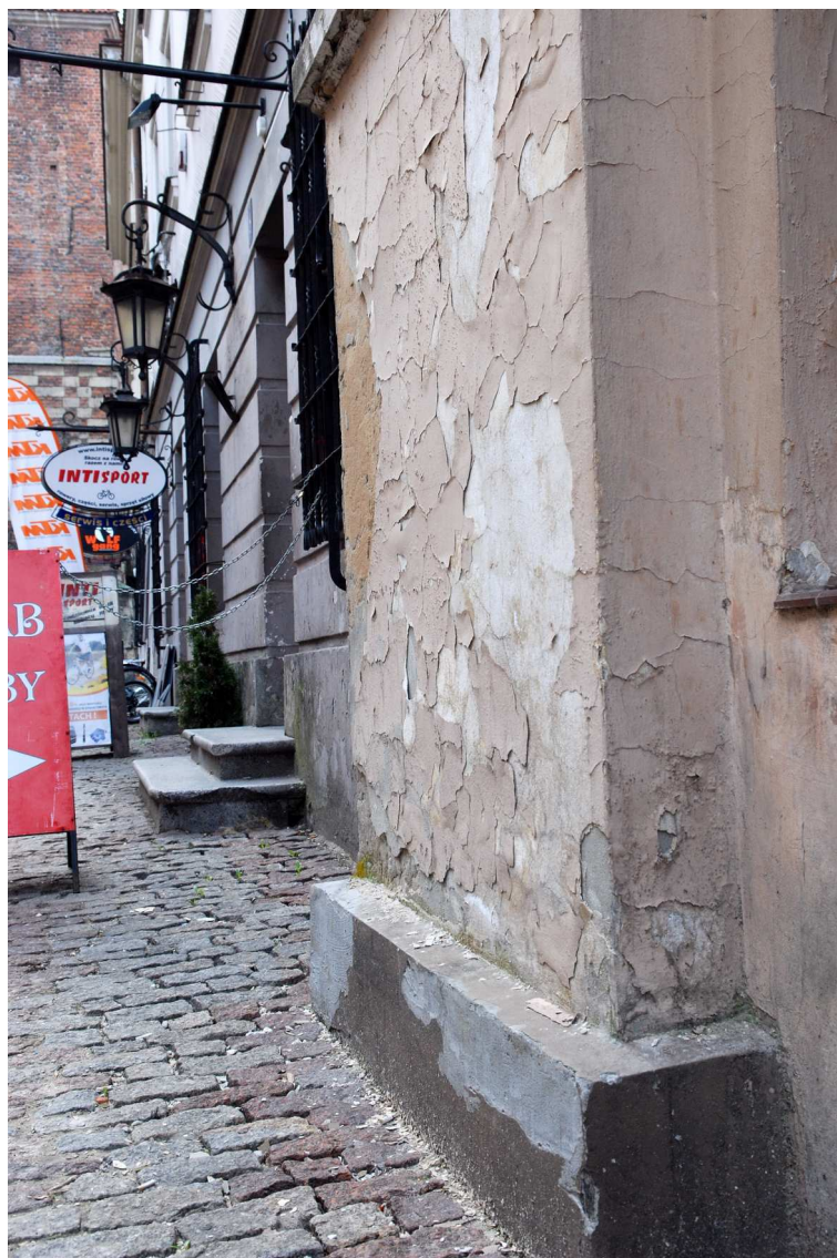
Fasada detale, Bramowa 8, fot. Marcin Moszyński, 2010.
