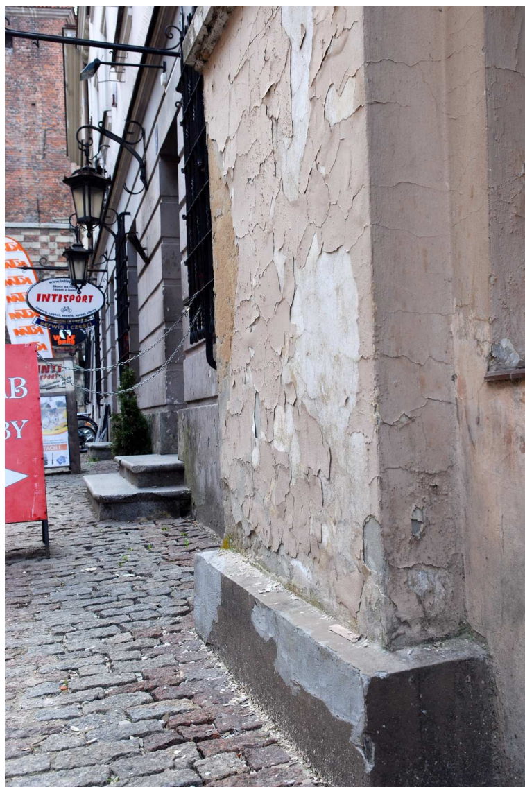
Fasada detale, Bramowa 8, fot. Marcin Moszyński, 2010.
