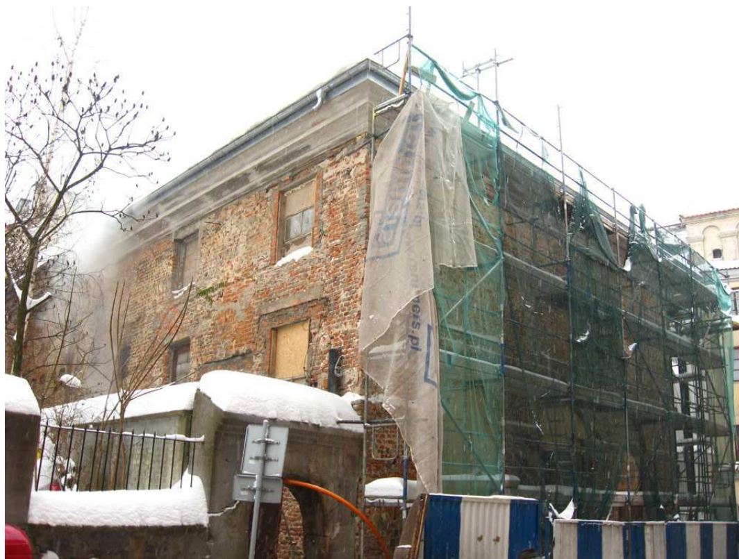
Teatr Stary w trakcie remontu, fot. Robert Sawa, 2010
