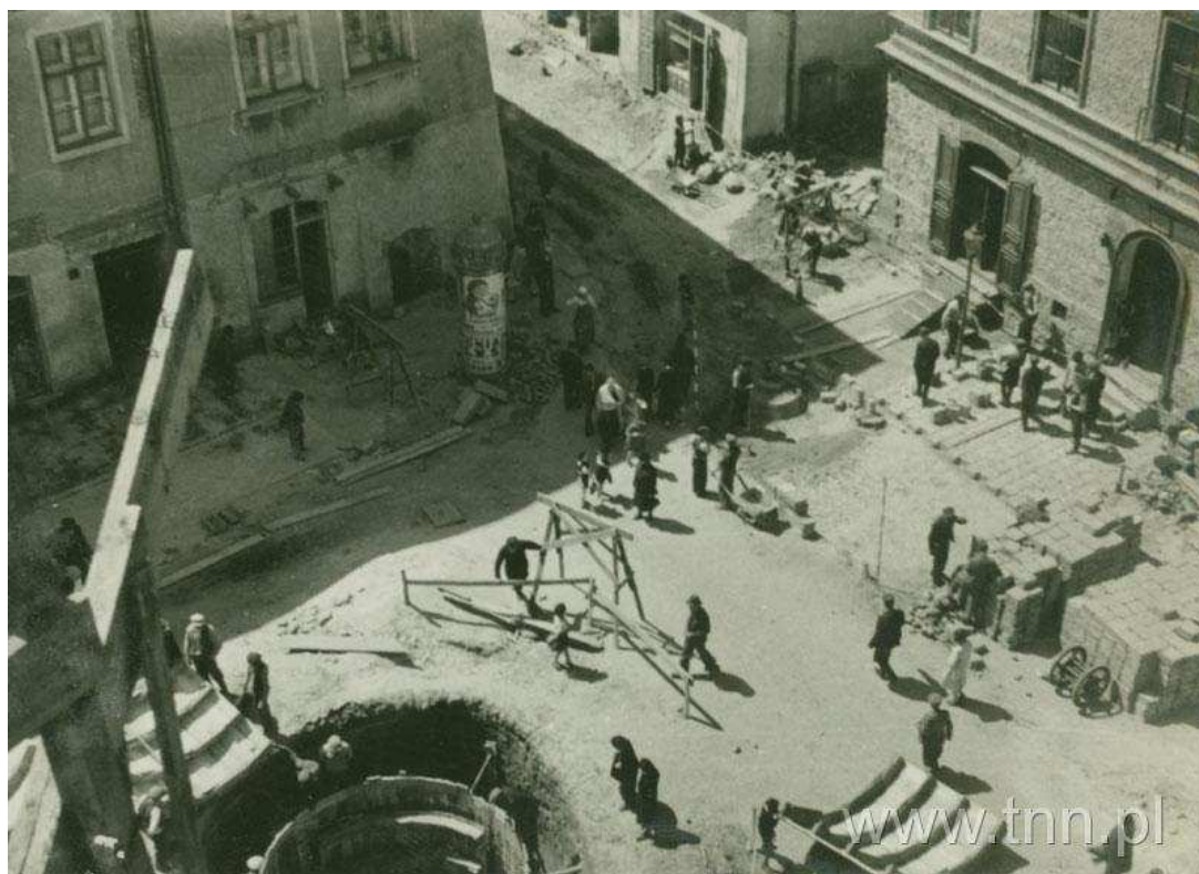
Roboty przy wykonywaniu bruku i zbiornika wodnego w Rynku, Grodzka 9/Archidiakońska 11, autor nie znany, 1938, Wydział Architektury, Budownictwa i Urbanistyki Urzędu Miasta Lublin
