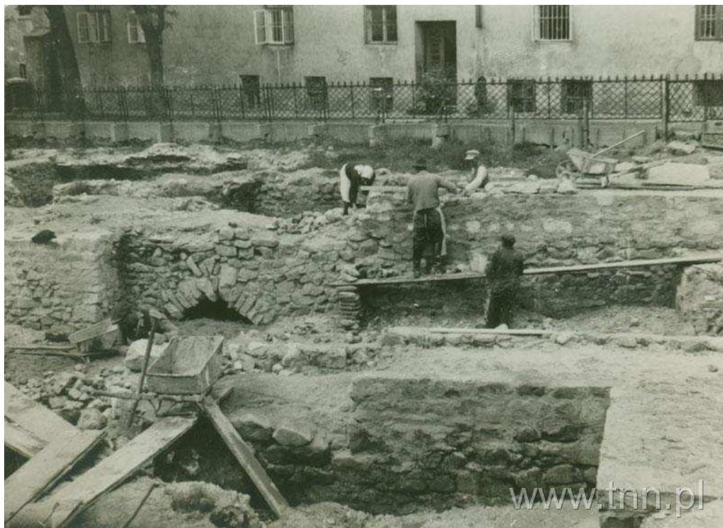
Prace konserwatorskie przy fundamencie dawnego kościoła św. Michała, Grodzka 9/Archidiakońska 11, autor nie znany, 1938, Wydział Architektury, Budownictwa i Urbanistyki Urzędu Miasta Lublin
