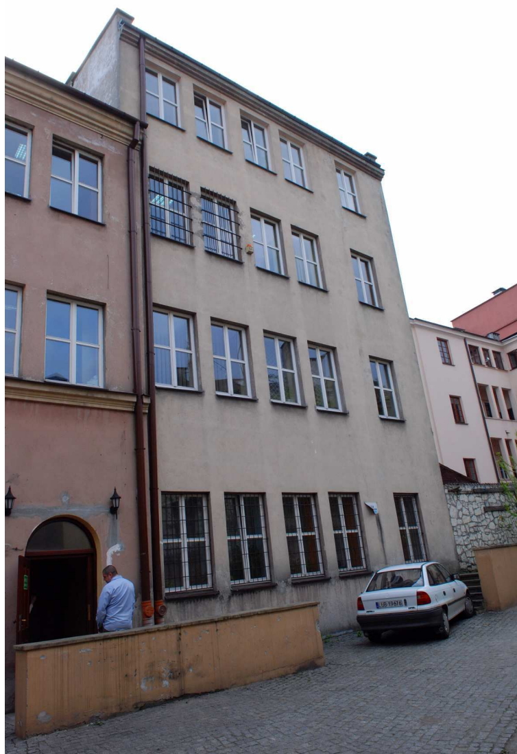
Elewacja tylna, Grodzka 12, fot. Marcin Moszyński, 2010.
