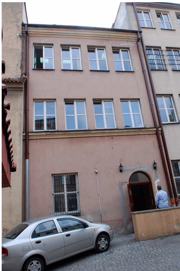
Elewacja tylna, Grodzka 12, fot. Marcin Moszyński, 2010.
