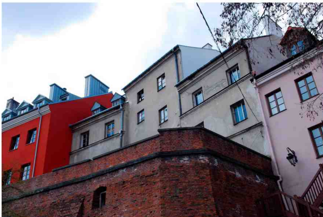
Elewacja tylna, Grodzka 17, fot. Marcin Moszyński, 2010.
