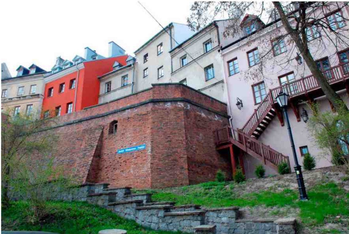
Elewacja tylna, Grodzka 17, fot. Marcin Moszyński, 2010.
