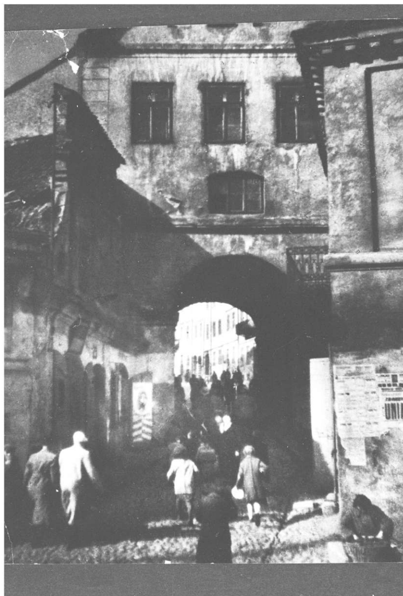
Brama Grodzka, Grodzka 23 - kamienica pierwsza od lewej, autor Edward Hartwig, ok. 1938, własność Ewa Hartwig-Fijałkowska.
