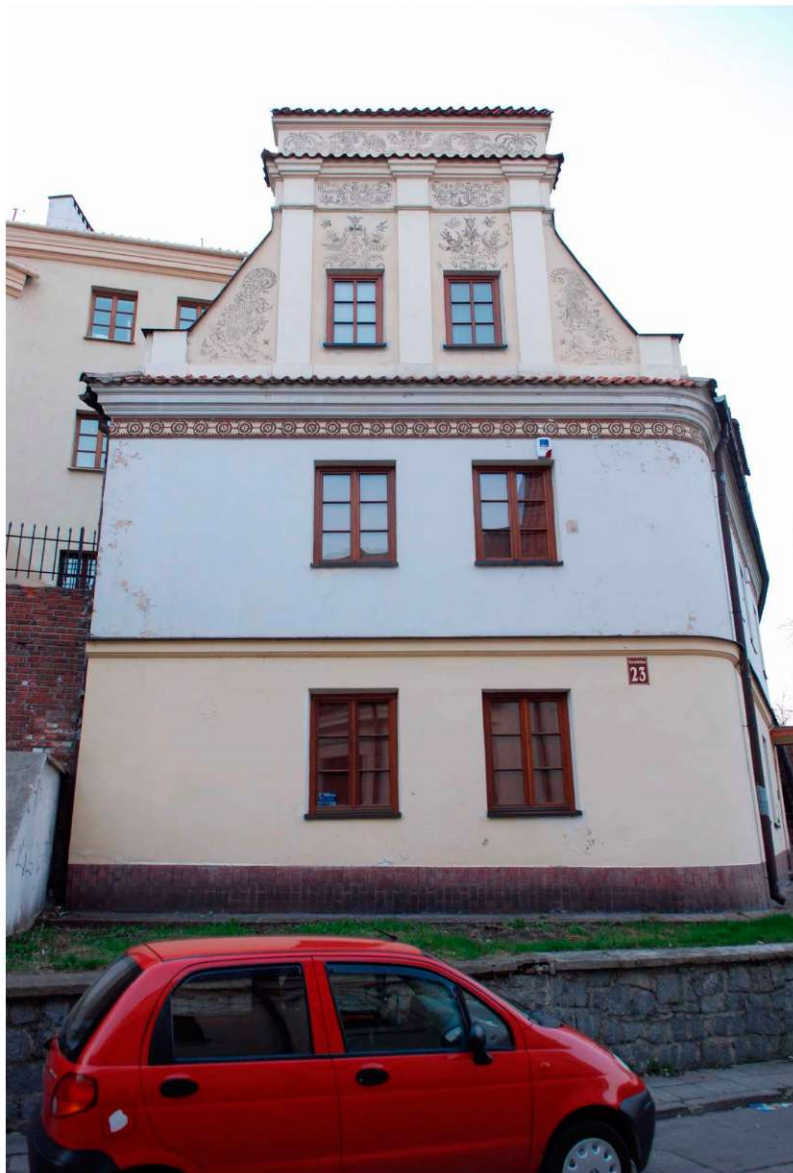
Elewacja tylna, widok od ul. Podwale, Grodzka 23, fot. Marcin Moszyński, 2010.
