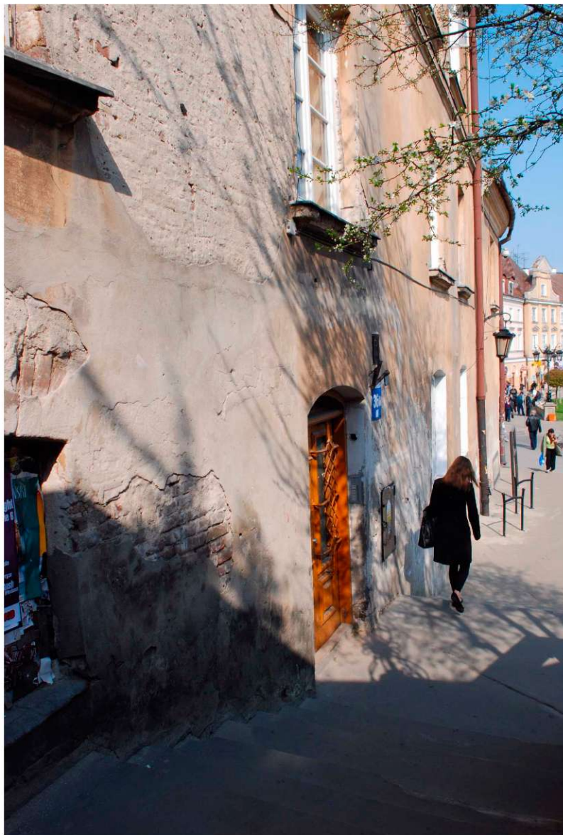
Elewacja główna, przyziemie, Grodzka 36a, fot. Marcin Moszyński, 2010.
