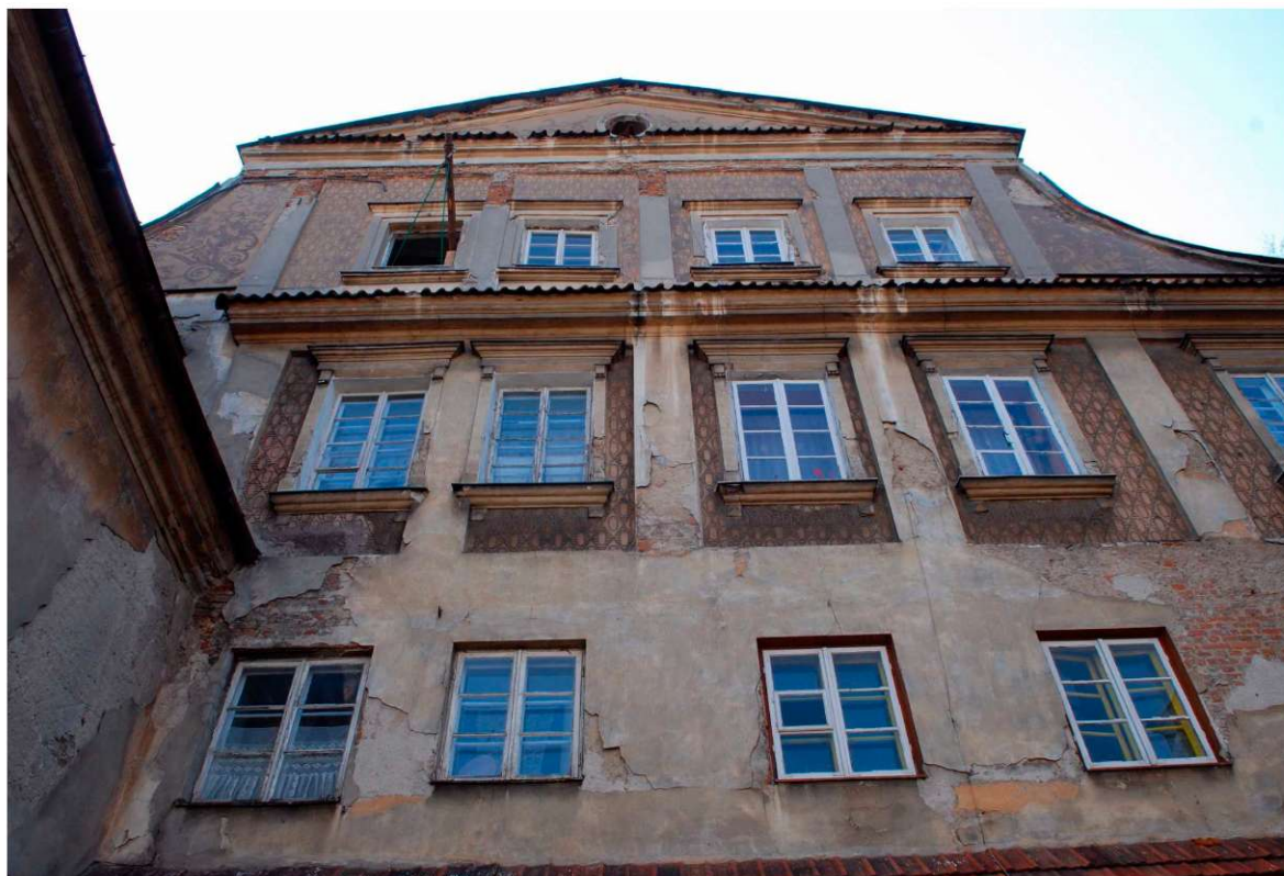
Ściana szczytowa kamienicy Grodzka 36, fot. Marcin Moszyński, 2010.
