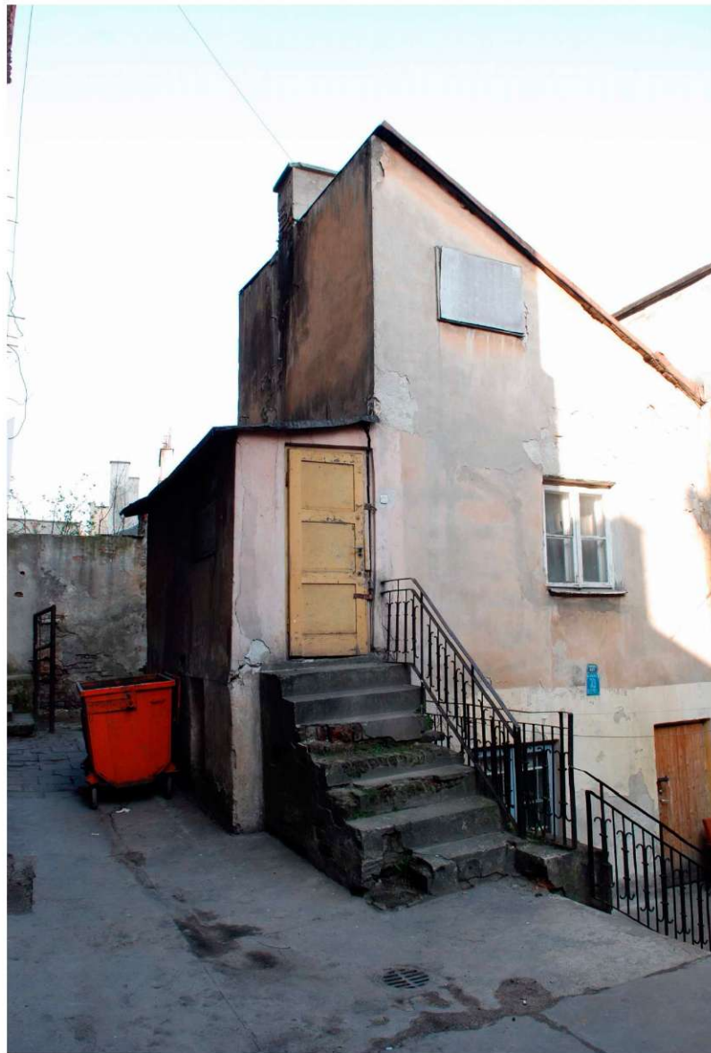
Elewacja tylna, widok od podwórka, Grodzka 36, fot. Marcin Moszyński, 2010.
