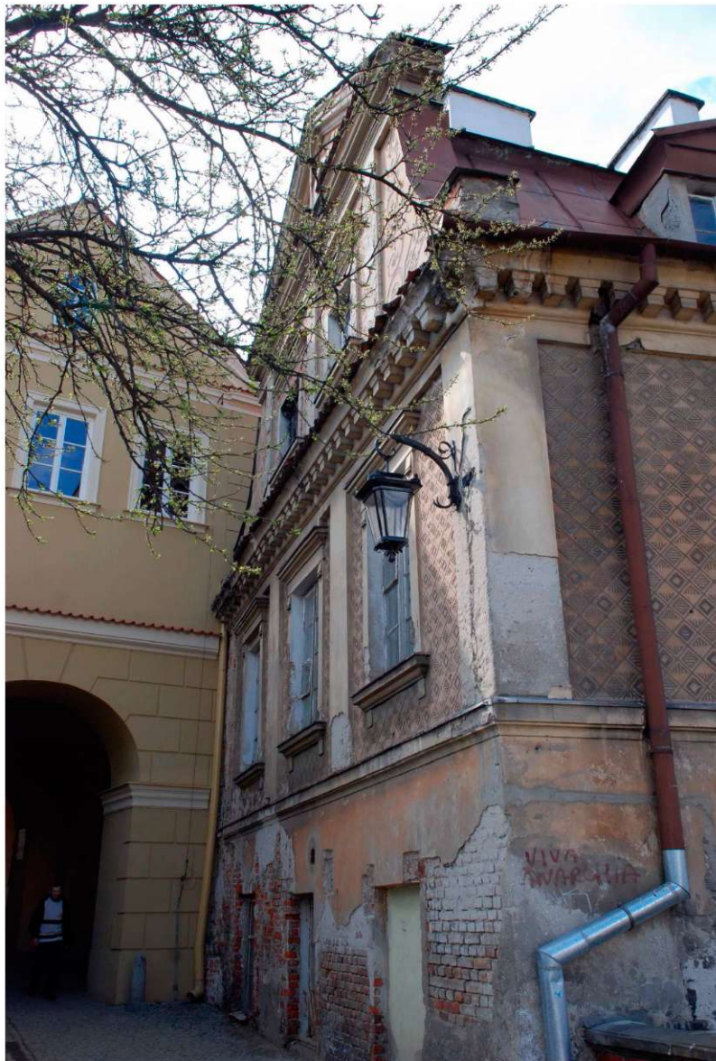
Elewacja boczna, Grodzka 36a, fot. Marcin Moszyński, 2010.
