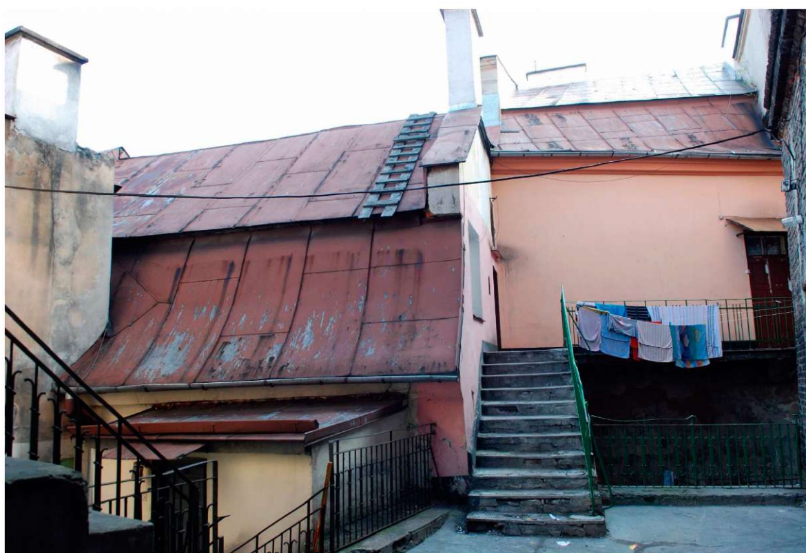
Elewacja tylna, widok od podwórka, Grodzka 36, fot. Marcin Moszyński, 2010.
