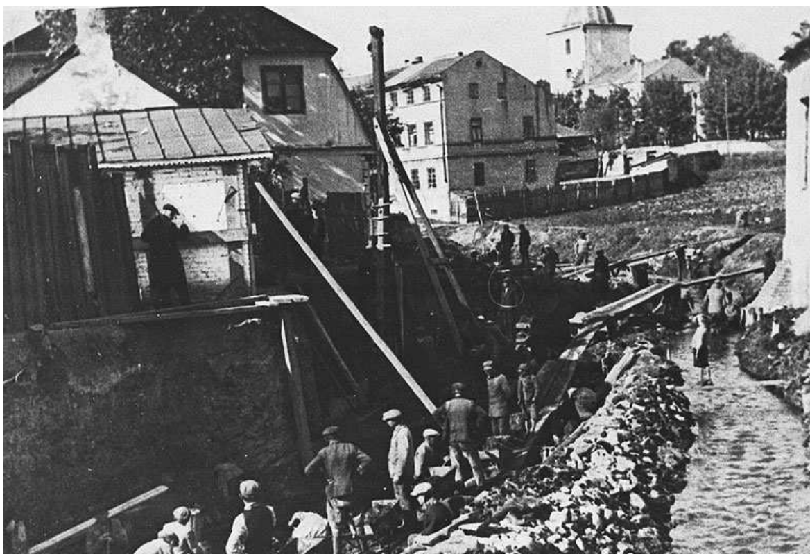
Jateczna 48, fragment nieruchomości, druga od lewej, prace przy regulacji Czechówki, autor nieznany, 1938.
