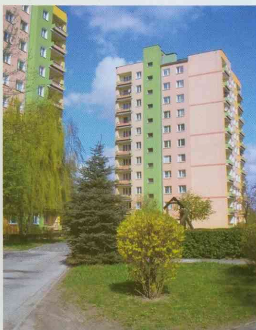
ul. Daszyńskiego – fot. K. Bielak
