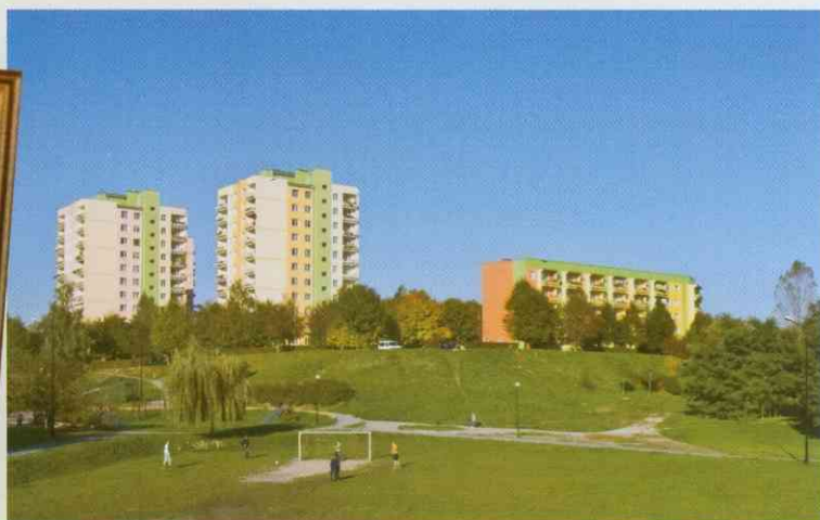
ul. Daszyńskiego – fot. K. Bielak
