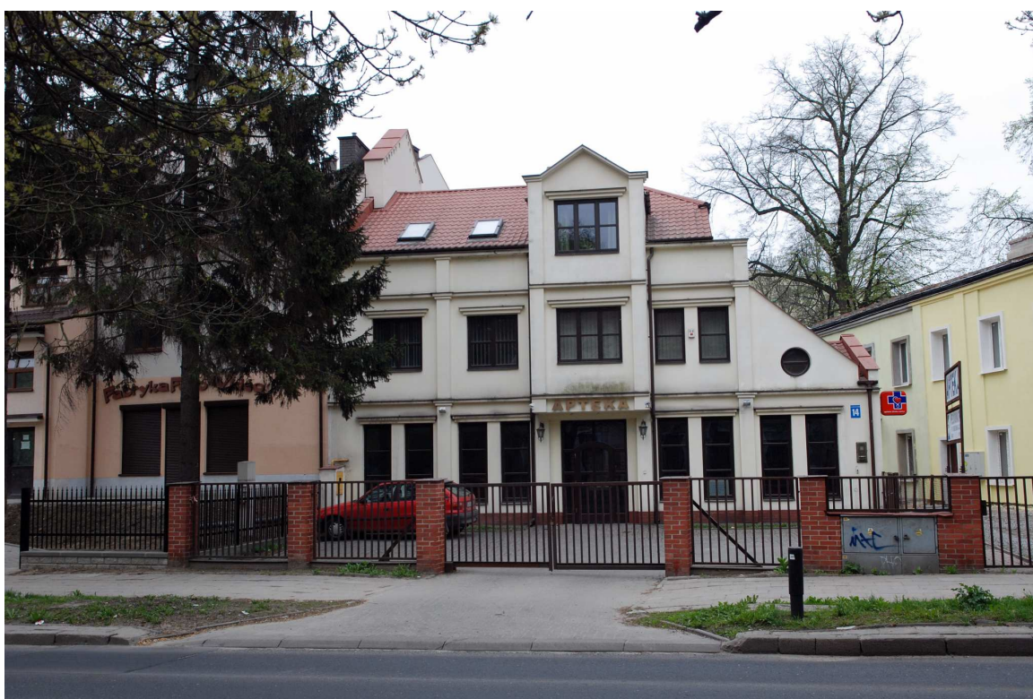
Elewacja główna, Biernackiego 14 dawniej Bonifraterska 18, fot. Marcin Moszyński, 2010.
