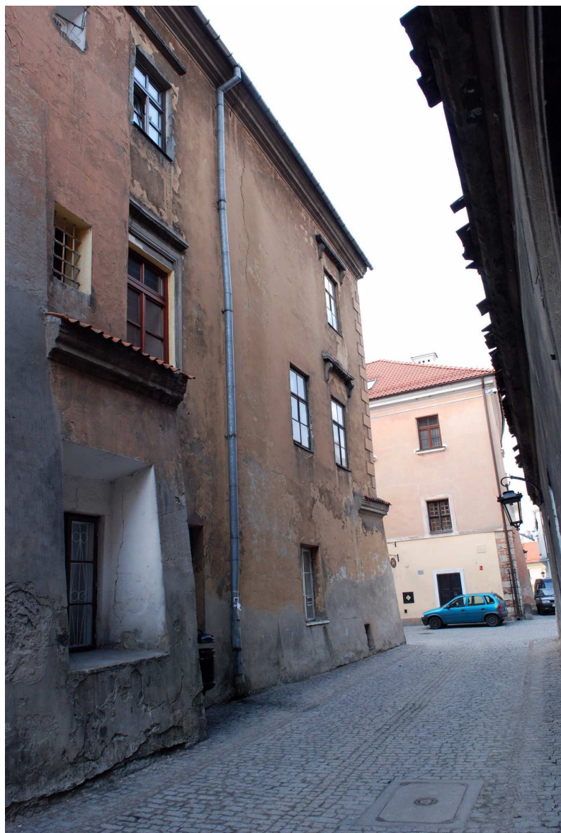
Elewacja boczna, Złota 5, fot. Marcin Moszyński, 2010.
