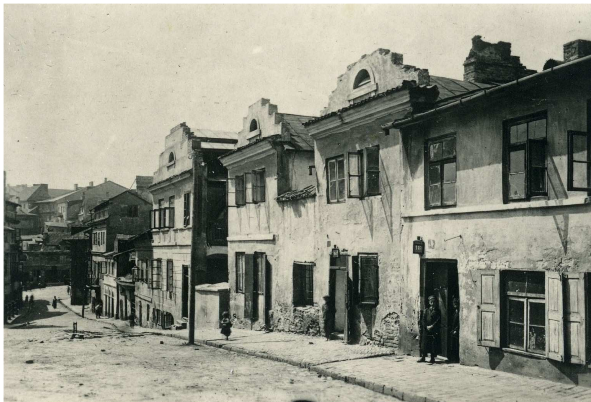
Zamkowa 16, nieruchomość druga od prawej, autor nieznany, 1918, Samorządowa Fototeka Konserwatorska, Miejski Konserwator Zabytków.
