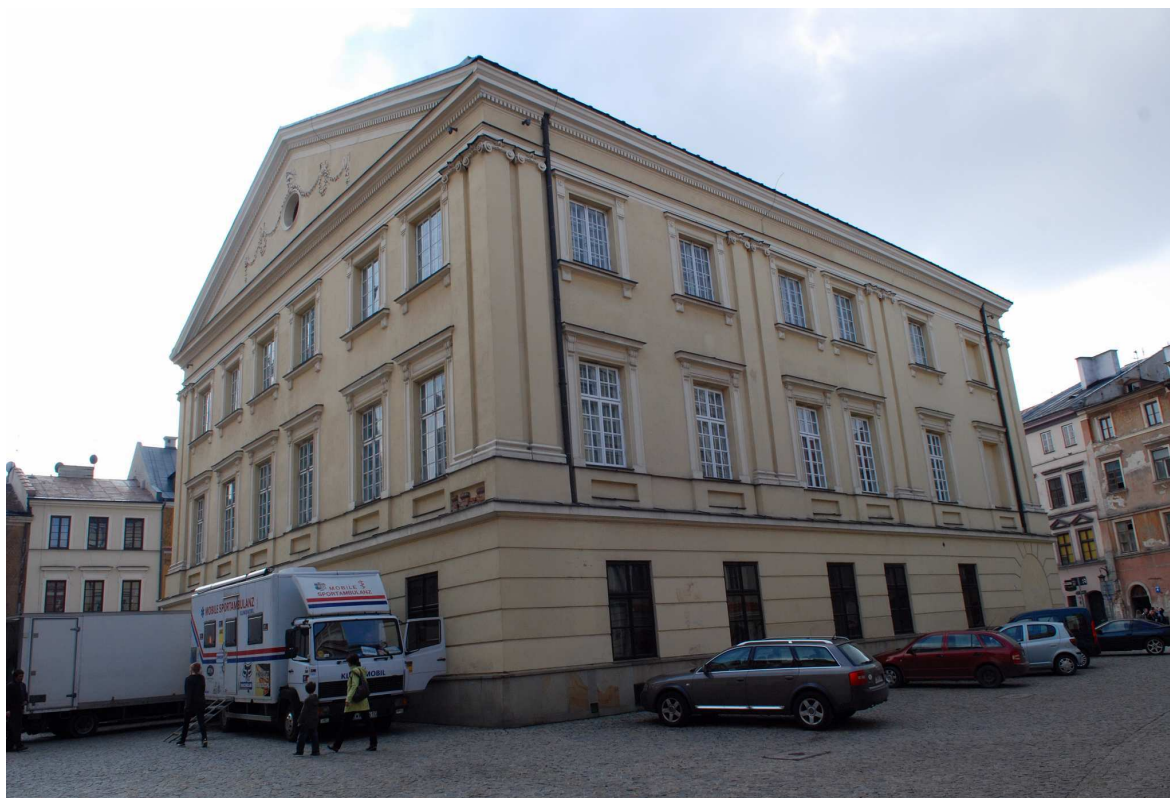
Fasada i elewacja boczna, Rynek 1, fot. Marcin Moszyński, 2010.
