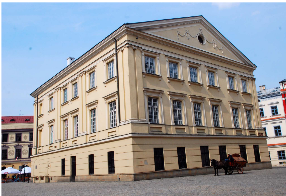
Elewacja boczna i tylna, Rynek 1, fot. Marcin Moszyński, 2010.
