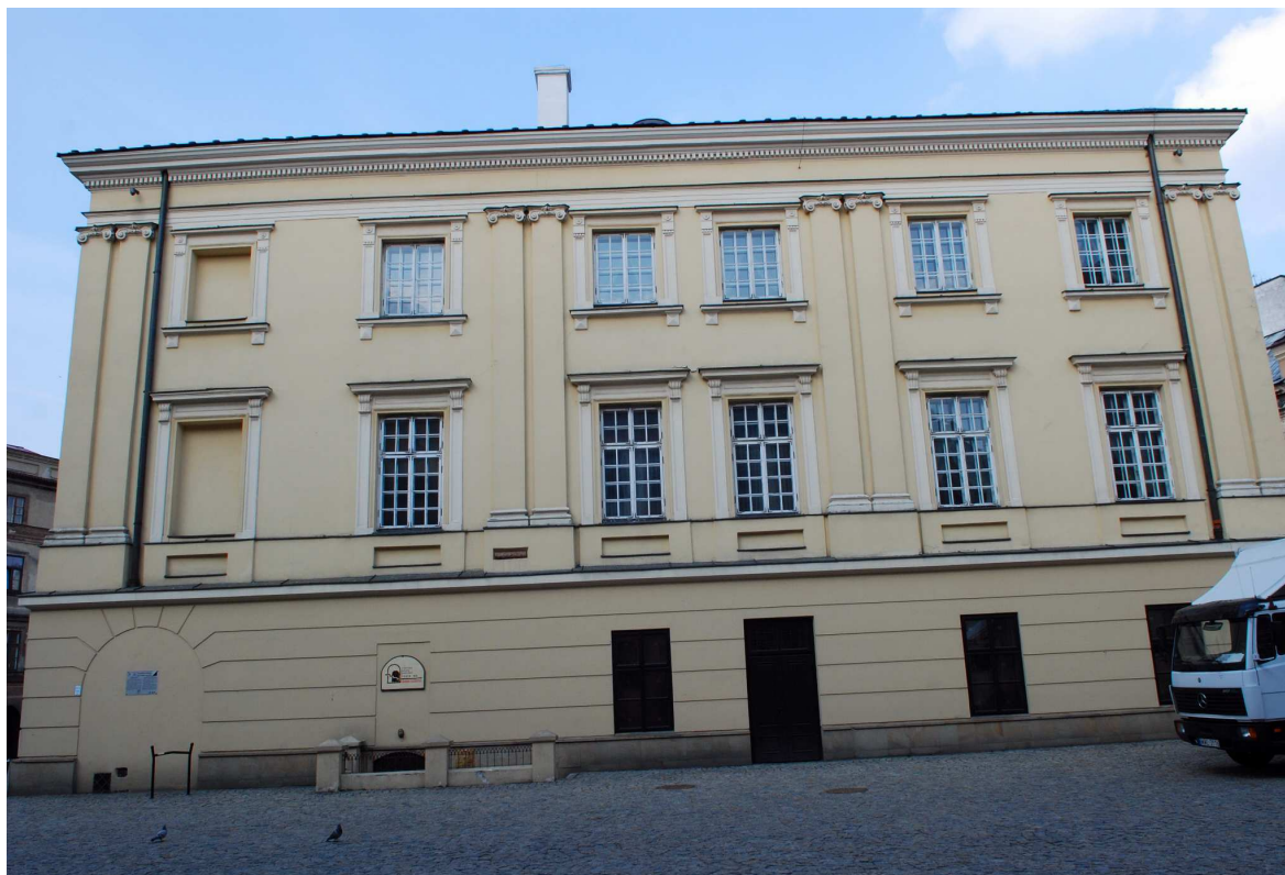
Elewacja boczna, Rynek 1, fot. Marcin Moszyński, 2010.
