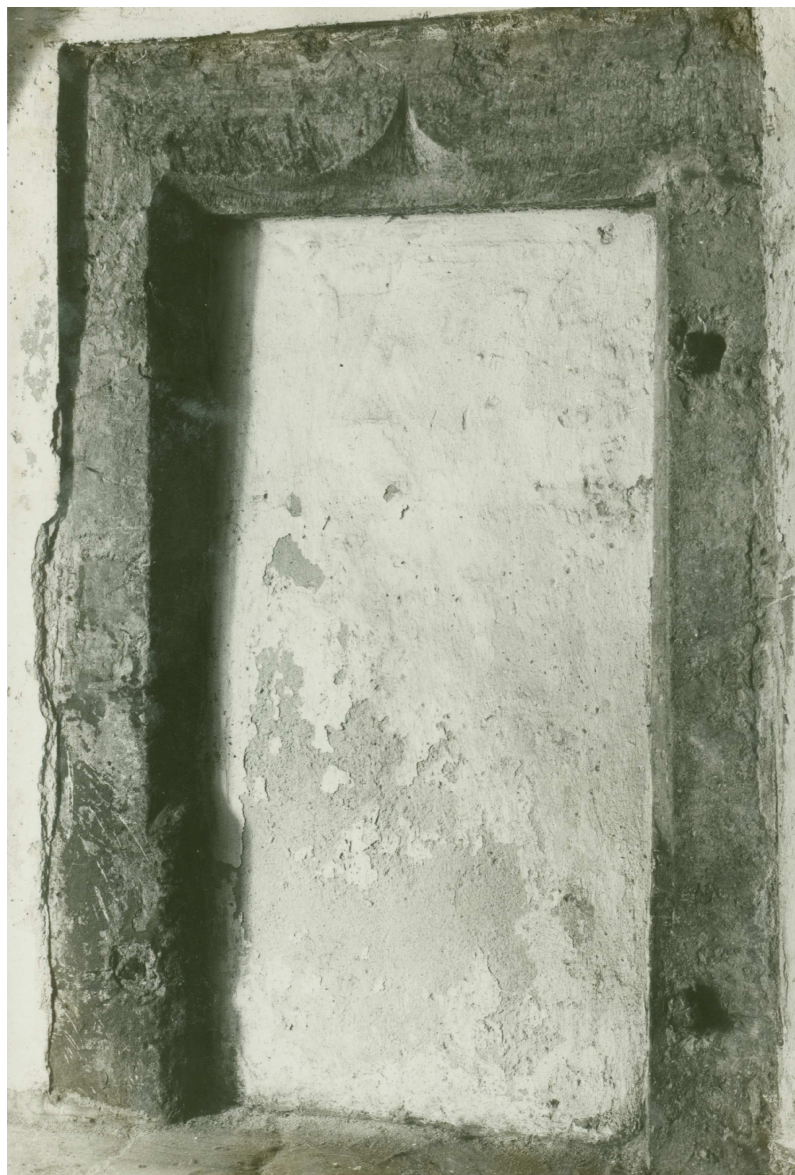
Rynek 3, portal kamienny, gotycki w sieni kamienicy, autor nieznany, zdjęcie z albumu „Zdjęcia z robót konserwatorskich Starego Miasta prowadzonych przez Wydział Budownictwa Zarządu Miasta w roku 1938-1939”, własność Miejski Konserwator Zabytków w Lublinie.
