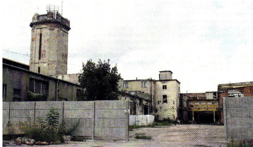
Ul. Zimna 3a. W 1942 roku wywieziono stąd lubelskich Żydów do obozu zagłady
