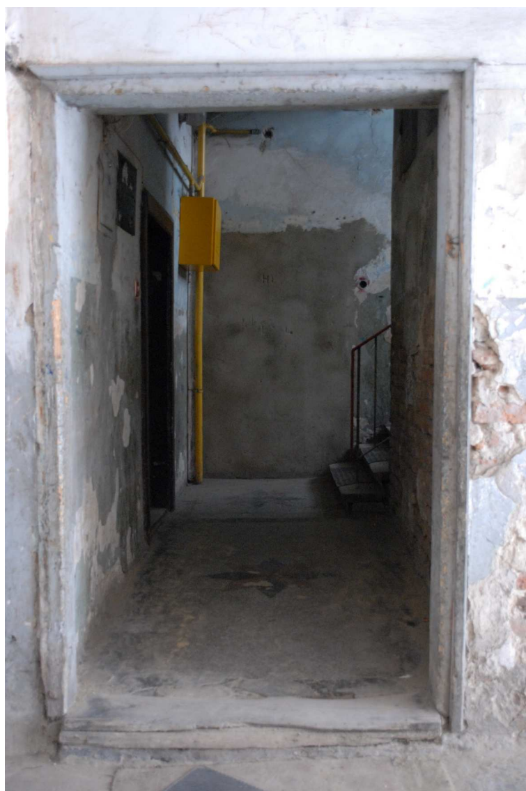
Klatka schodowa, Rybna 4, fot. Piotr Sztajdel, 2010.
