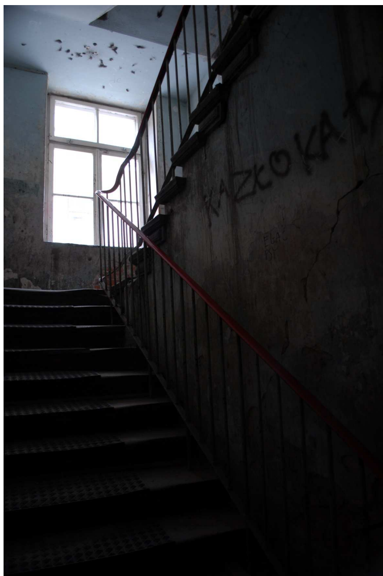
Klatka schodowa, Rybna 4, fot. Piotr Sztajdel, 2010.
