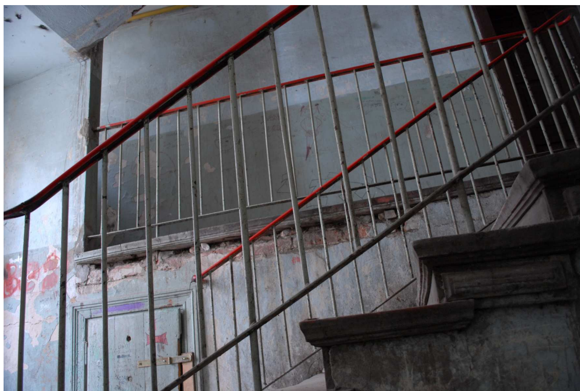
Klatka schodowa, Rybna 4, fot. Piotr Sztajdel, 2010.
