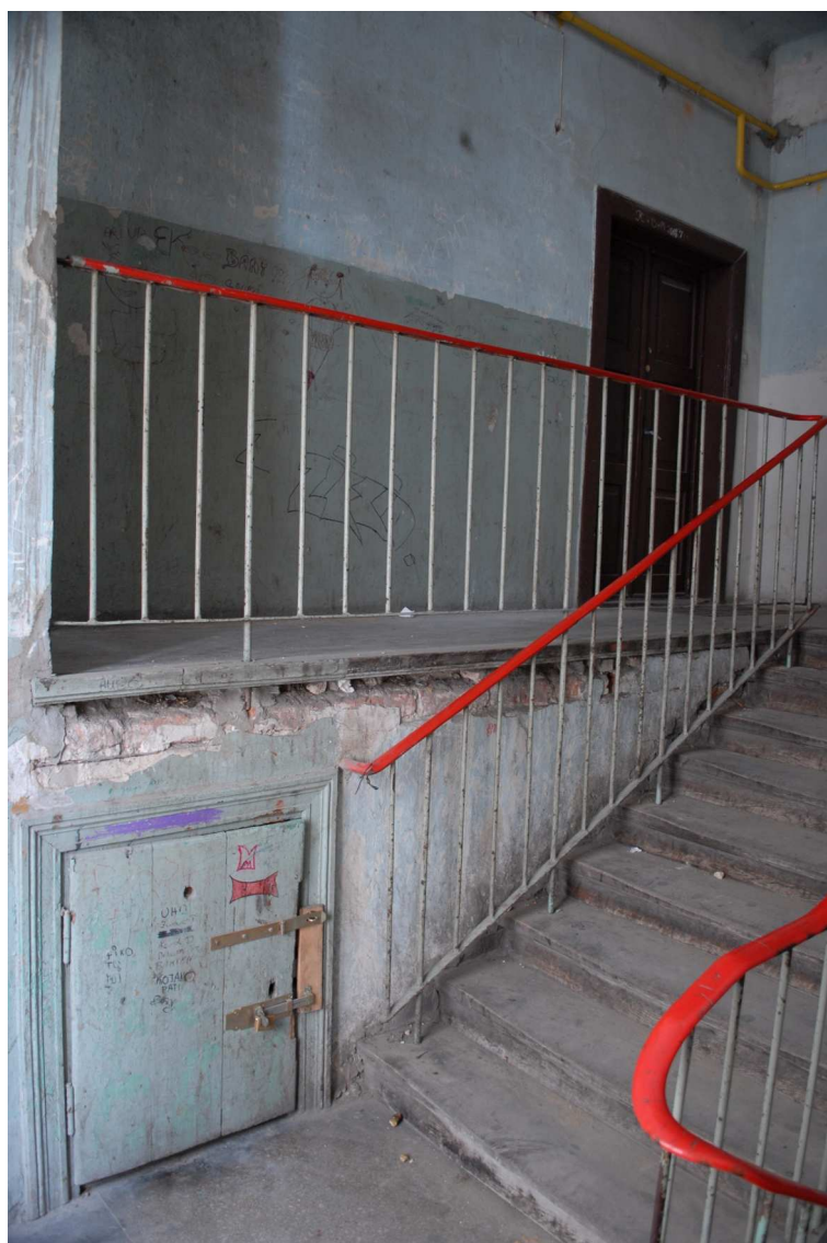
Klatka schodowa, Rybna 4, fot. Piotr Sztajdel, 2010.
