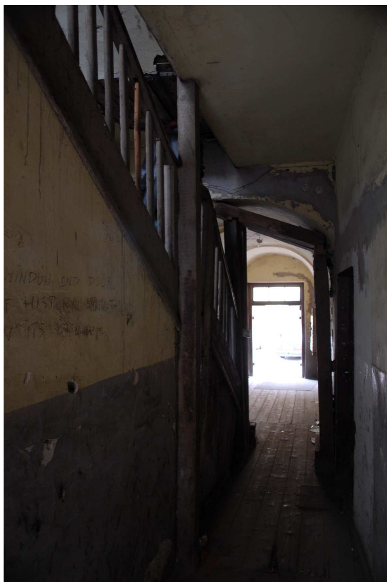
Klatka schodowa, Rybna 6, fot. Piotr Sztajdel, 2010.
