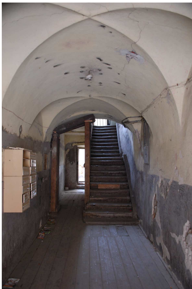
Klatka schodowa, Rybna 6, fot. Piotr Sztajdel, 2010.
