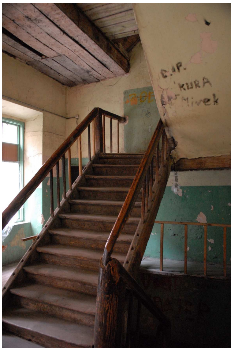
Klatka schodowa, Rybna 10, fot. Piotr Sztajdel, 2010.
