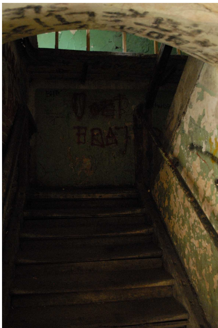
Klatka schodowa, Rybna 10, fot. Piotr Sztajdel, 2010.
